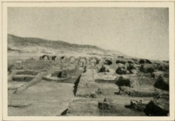
FIG. 273. — LES MAGASINS VOÛTÉS EN BRIQUES AU RAMESSÉUM. (Cliché Baraïze.)
