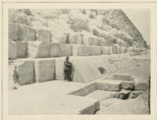
FIG. 75. — LES ASSISES CONSERVÉES AU REVÊTEMENT DE LA GRANDE-PYRAMIDE. (Cliché Covington.)
