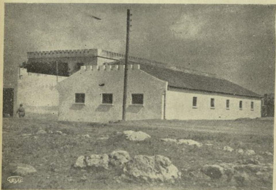
اصطبل للدرك في اللاذقية وتبلغ مساحة البناء ٢٩٠ متراً مربعاً
