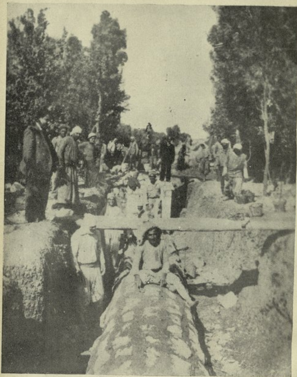
تحسين ينابيع حيلان ورشة اكساء القناة بالبناء مع انشاء فوهات للتغزير
