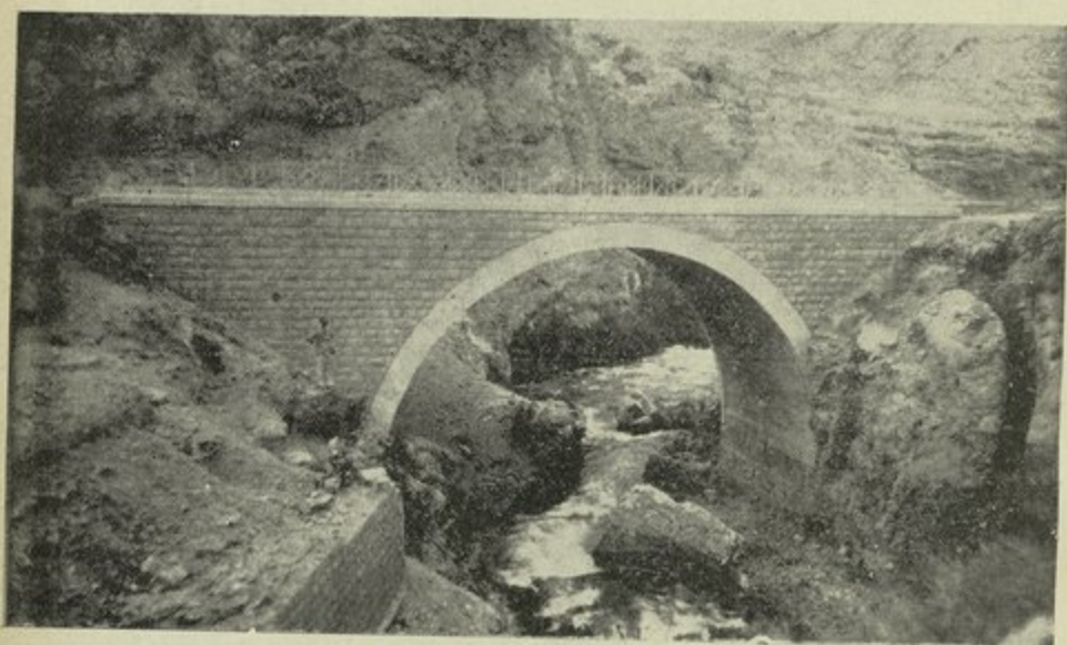
جسر ذو فتحة ١٥ متر على بردى في موقع التكية على طريق الفيحة التكية وهو يؤمن الاتصال بين مصايف وادي بردى وبين مصايف منطقة الزبداني
