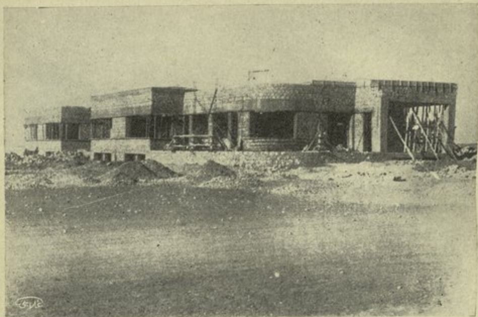
مستشفى القامشلي - منظر احدى زوايا البناء
