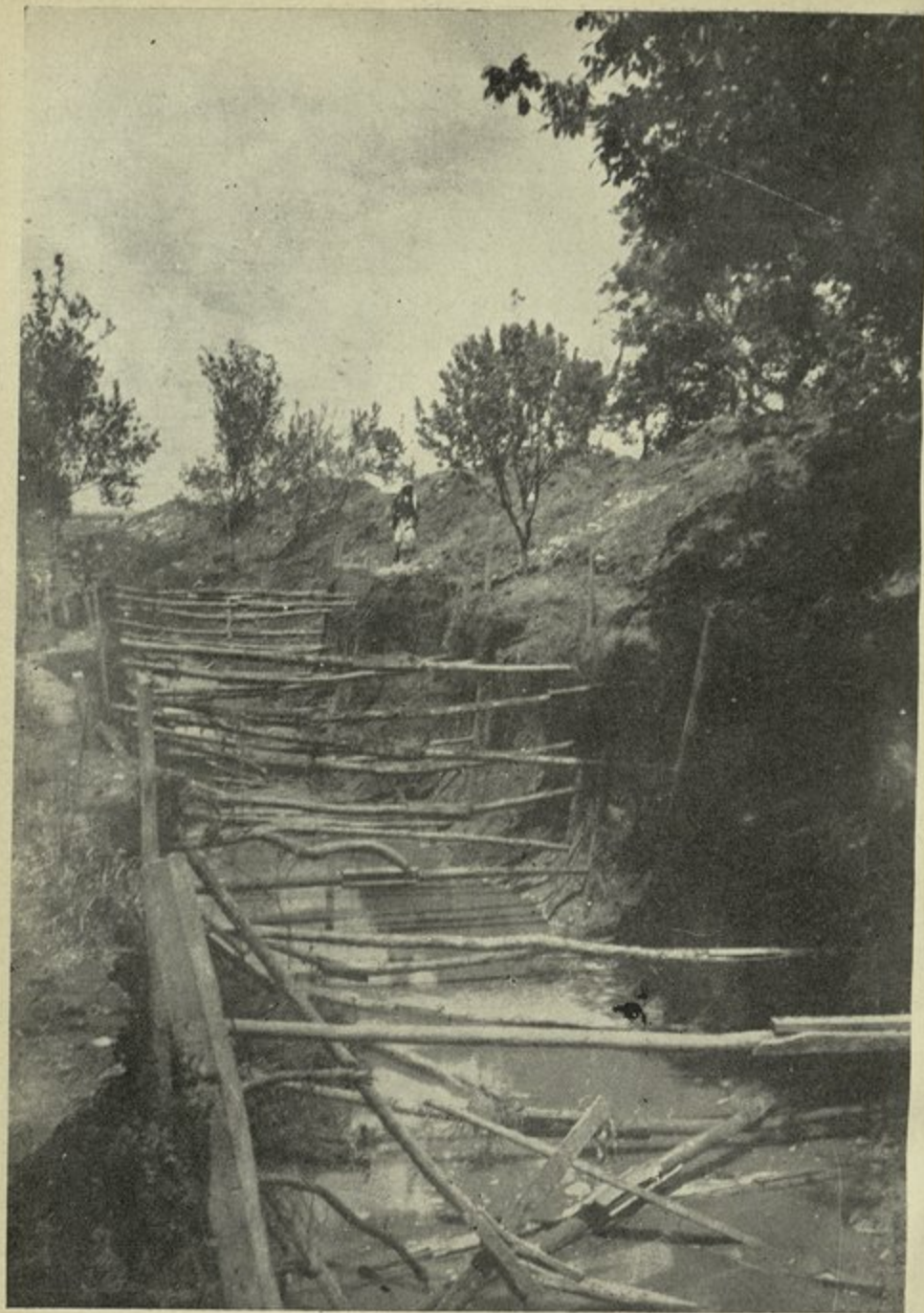
اعمال تحسين بناييع حيلان ورشة حفريات قناة الاستجرار وقد بلغ عمقها في بعض الاقسام ما يزيد على الستة امتار
