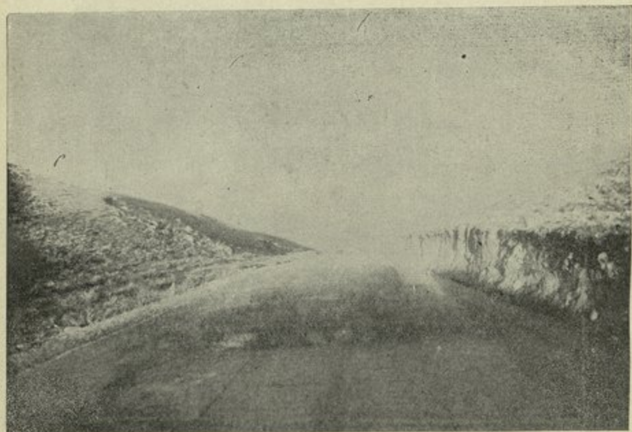
منظر التحويلة الرابعة من طريق دمشق بيروت بين الكيلومتر (٣٠) والكيلومتر (٣٣) وقد استغني بواسطتها عن عدة منعطفات صعبة في الطريق
