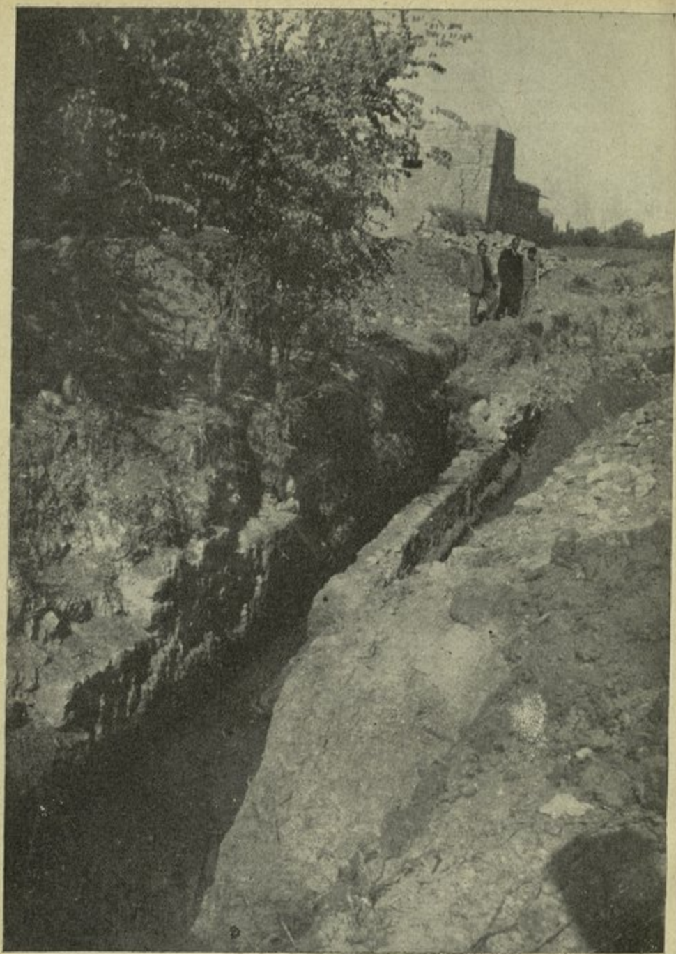
اعمال تحسين ينابيع حيلات صورة القناة الرومانية التي ظهرت في قعر الحفريات بعمق خمسة امتار عن سطح الارض
