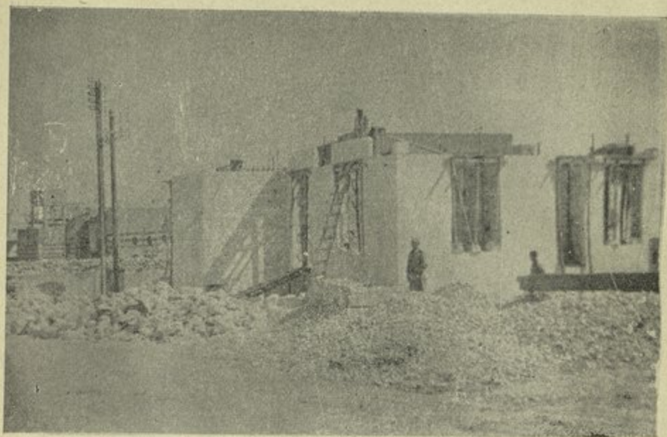
مستوصف حماه - منظر الواجهات اثناء البناء
