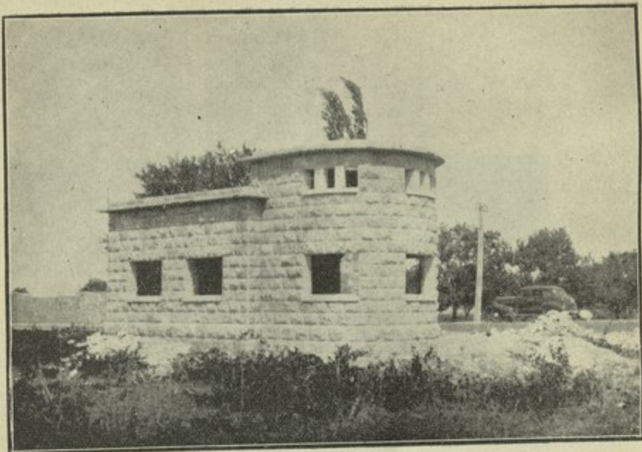
مشروع اسال مياه معرة النعمان - صورة غرفة النزحيات المنشأة فوق بئر الاستجرار في وادي النسيم
