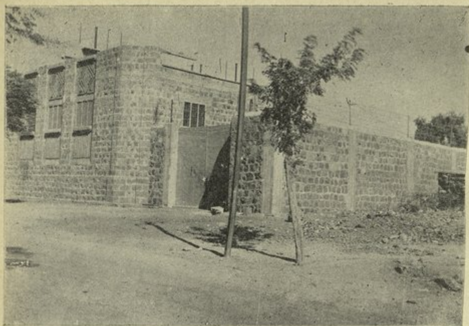
بناء جناح في سجن درعا وتظهر التصوينة التي بنيت حديثاً
