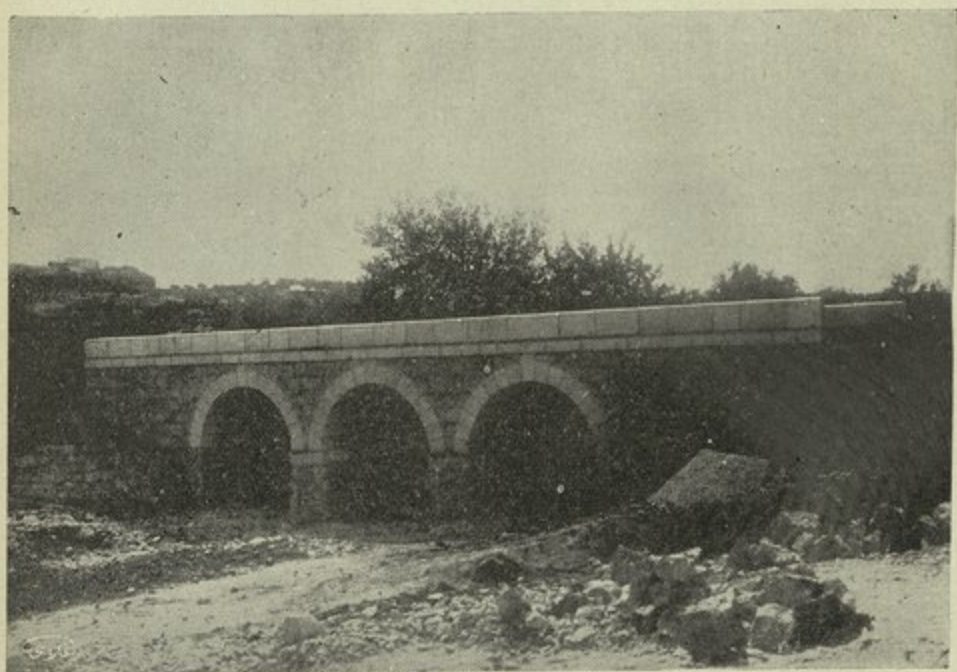
جسر ذو ثلاث فتحات كل منها ثلاثة امتار على طريق معرة النعمان - اربحا
