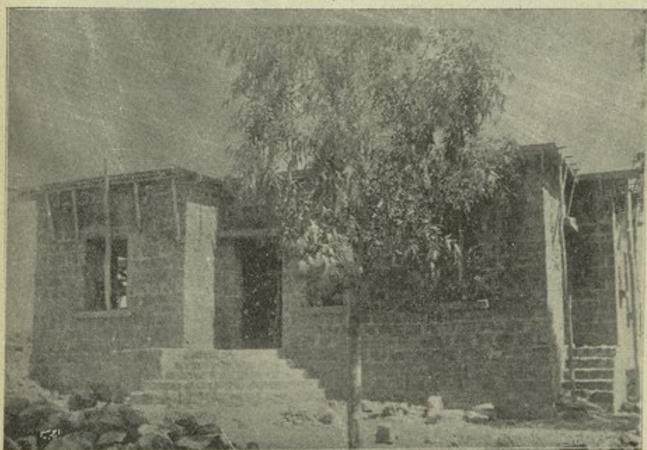
منظر ورشة بناء مستوصف الزوية ( فيق )
