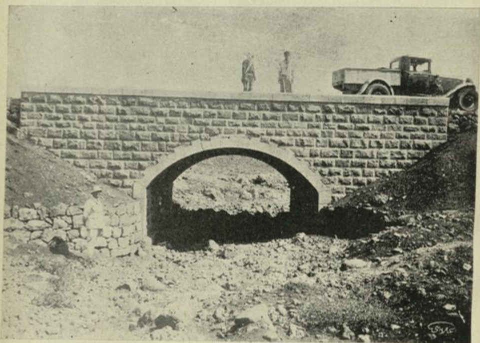
جسر ذو فتحة خمسة امتار على طريق درعا - بصرى اسكي شام
