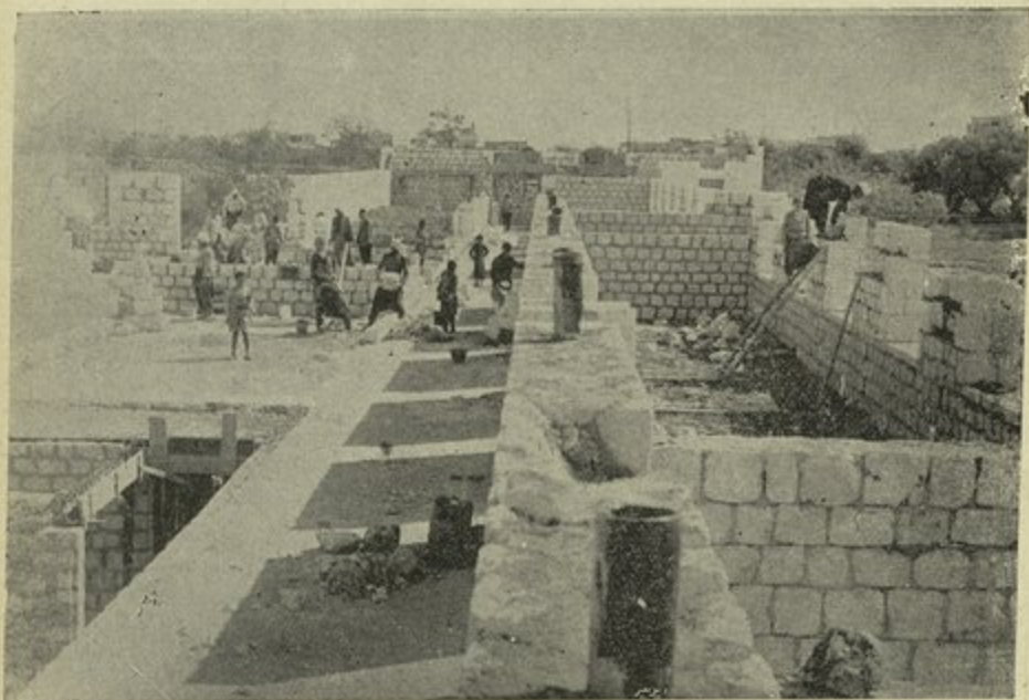
مستشفى ادلب - منظر الورشة اثناء البناء
