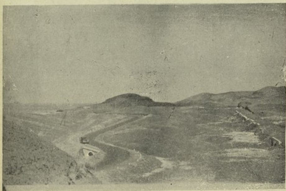
منظر لقسم من طريق اللاذقية-طرابلس حيث تقوم مصالح الاشغال العامة بازالة المنعطفات الخطرة ويظهر على اليمين الصورة الطريق الجديد المستقيم وعلى الشمال الطريق القديم ذي المنعطفات
