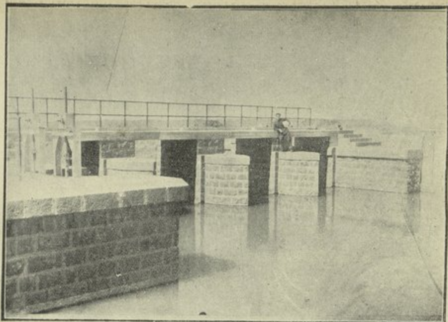
السد على نهر مزيريب ويقع بالقرب من بحجة مزيريب وتنبثق منه قناتان وترى الحواجز الحديدية على جانبي السد وهي تنظم جريان المياه في هاتين القناتين
