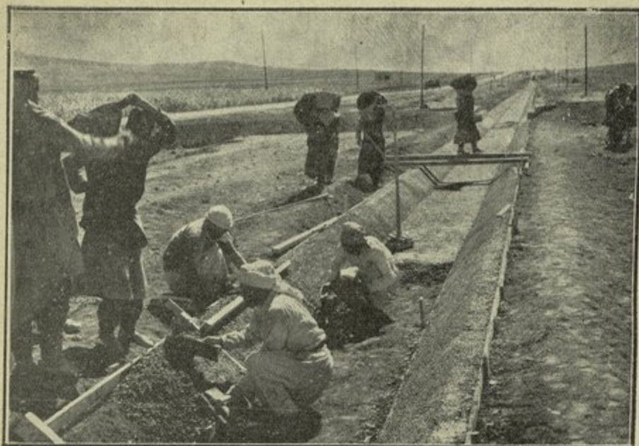
مشروع ري حمص وحماء - القناة الثانوية رقم ٩ التي تسير بجذاه الطريق العام من قرية آيو حتى حماء وتروي ١٤٠٠ هكتار ( اعمال اكساء اليبتون لقاع القناة وجدرانها )
