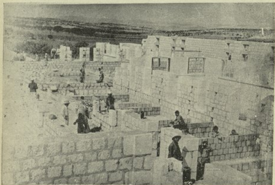
منظر آخر للورشة اثناء البناء
