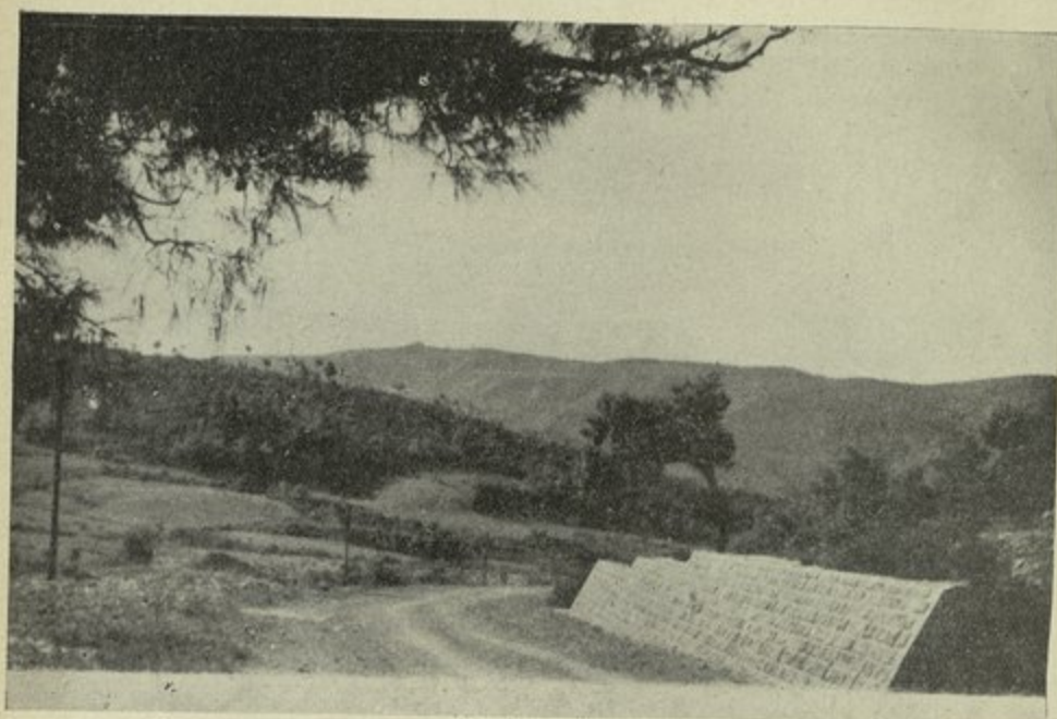
منظر الجدار الاستنادي الذي تم بناؤه على طريق اللاذقية انطاكية على طول ٤٠ متر في الموقع الكيلومترى ٤٤.
