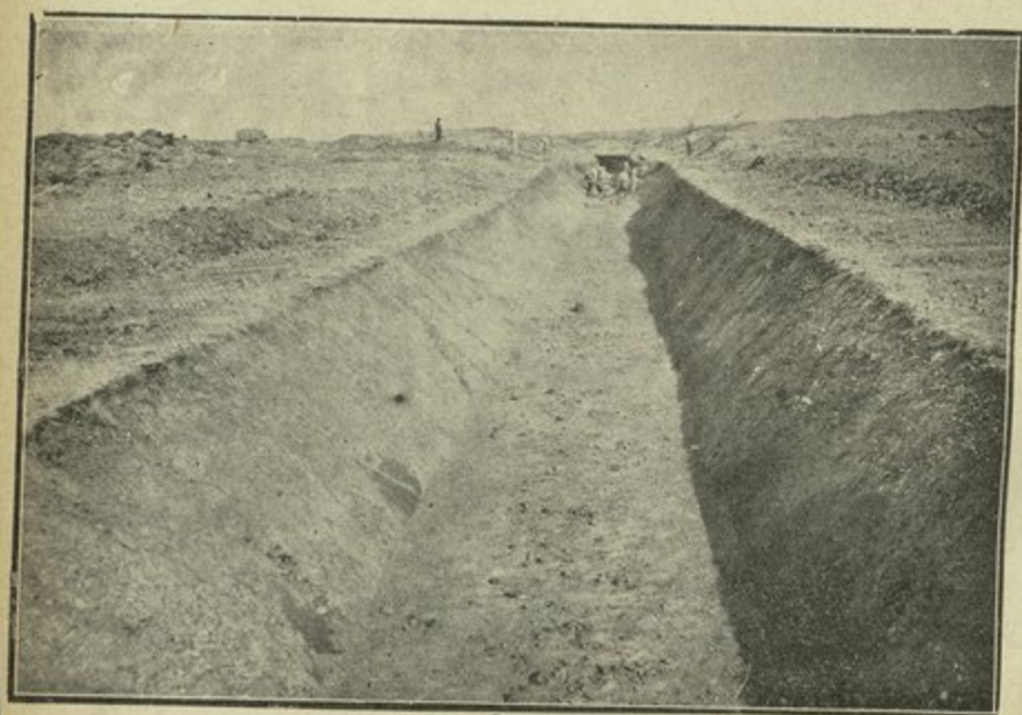
تجفيف مستنقع قزحل (مساحته ٧٢ هكتار) اعمال الحفريات في القسم الترابي من خندق التصريف
