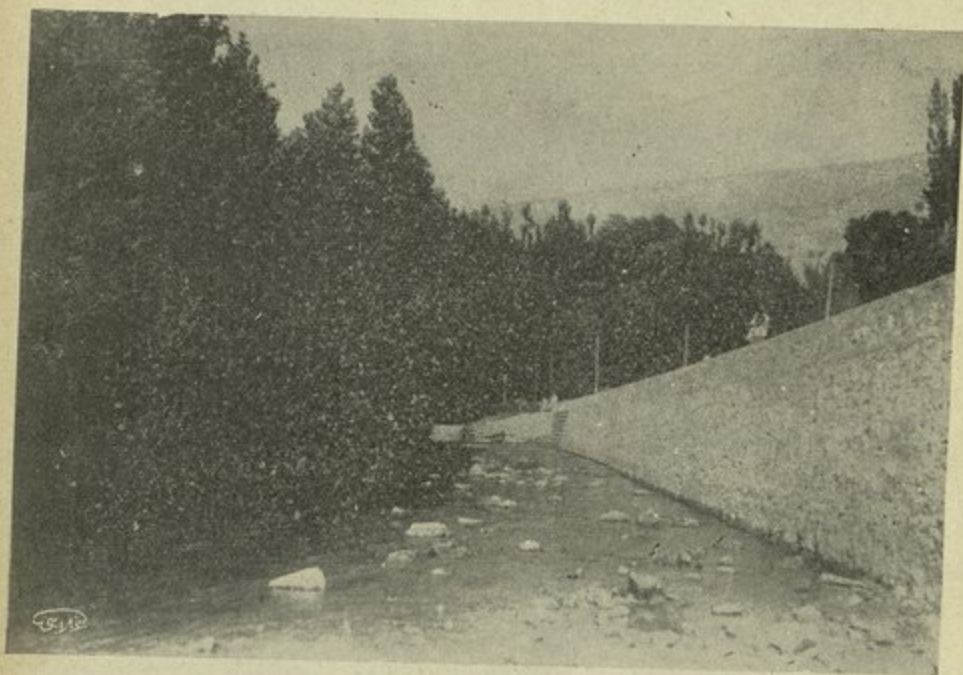
منظر الجدار الاستنادي الذي تم بناؤه على نهر يدي لتعريض طريق دمشق-بيروت بالقرب من الممر الثاني للسكة الحديدية في دمر ( كيلومتر ٦ )
