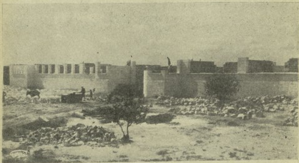
منظر ورشة بناء المدرسة الاكفالية للبنين في ادلب (تبلغ مساحة البناء ١٥٢٥ متر مربع) ويحتوي على ٢٦ غرفة تدريس وقاعتين
