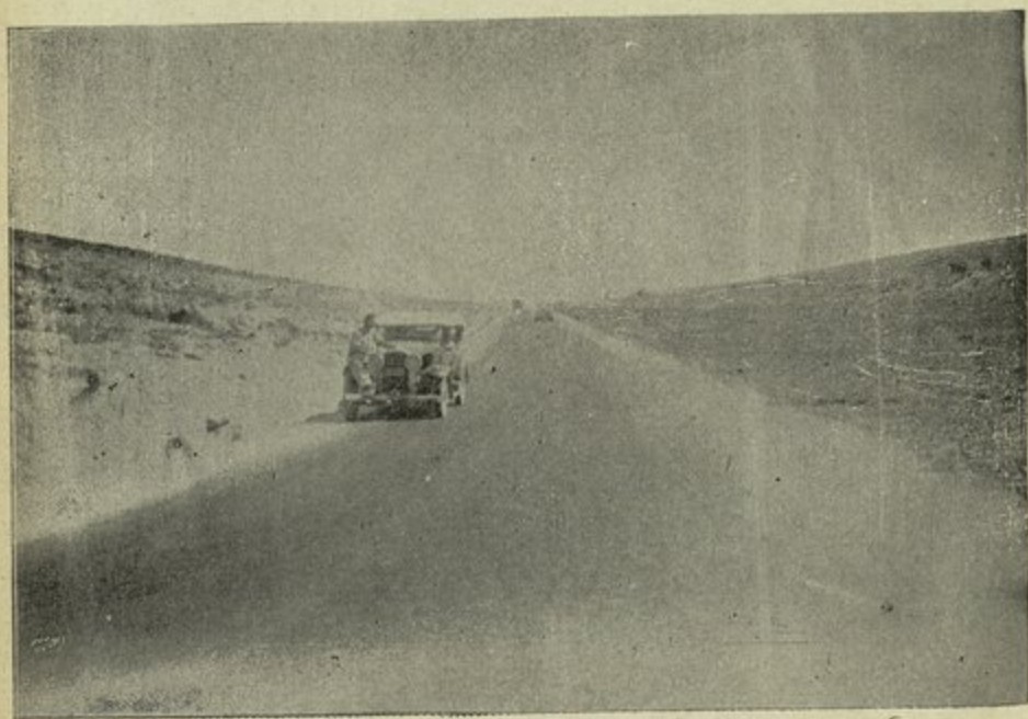
منظر التحويلة الثانية من طريق دمشق - بيروت في الكيلومتر ٢٤ وقد اختصرت بواسطتها عدة منعطفات
