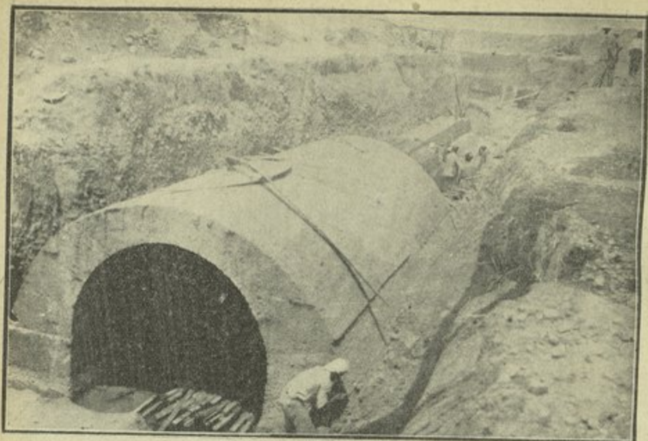
المأخذ الرئيسي لقناة تل مغاص - الحسكة صورة النفق الارضي المنشأ بين النهر ورأس القناة ويبلغ طوله تسعين متراً وعرضه ثلاثة امتار
