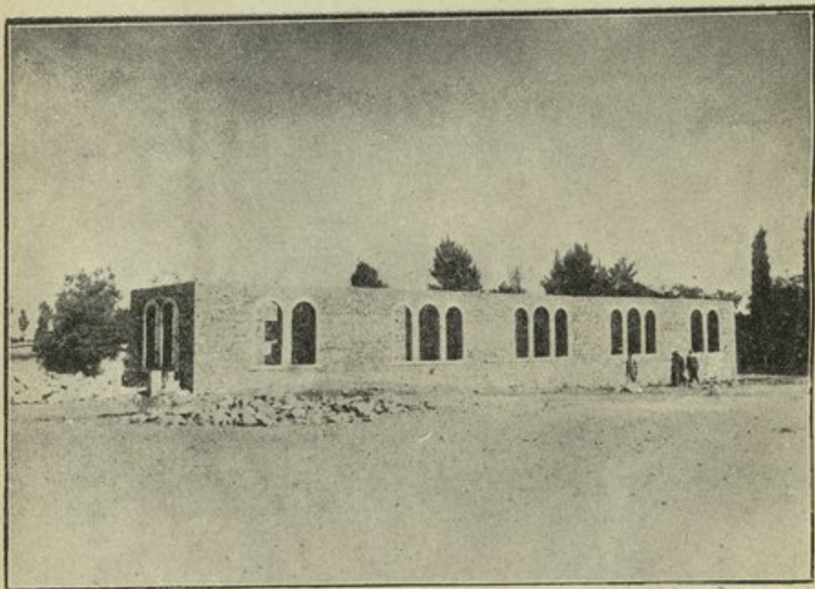
منظر مدرسة داريا اثناء البناء
