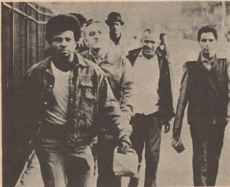
TRABAJADORES DE CONSTRUCCION CARGAN MANGUERAS ATRAVEZ DE LA LINEA DE PIQUETES EN EL PROYECTO DE VIVIENDA KAWAIDA EN NEWARK AYER. LAS MANGUERAS FUERON USADAS PARA REMOVER EL AGUA DEL PROYECTO QUE HA SIDO PARADO.
