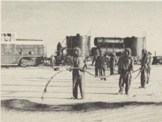
رش فسحة الطريق بالزيت الخام منعاً للرمال من الانهيار فوق القضبان الفولاذية وتغطيتها
