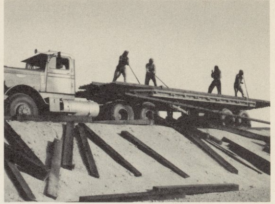
تفريغ القضبان الفولاذية من عربة نقل كبيرة بجانب الاربطة الخشبية في مقدمة الصورة
