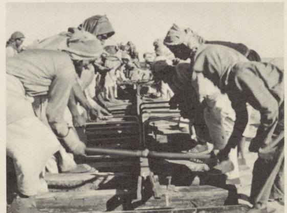
عمال آخرون يقومون بعملية مد القضبان الفولاذية بعد رصفها واحكامها
