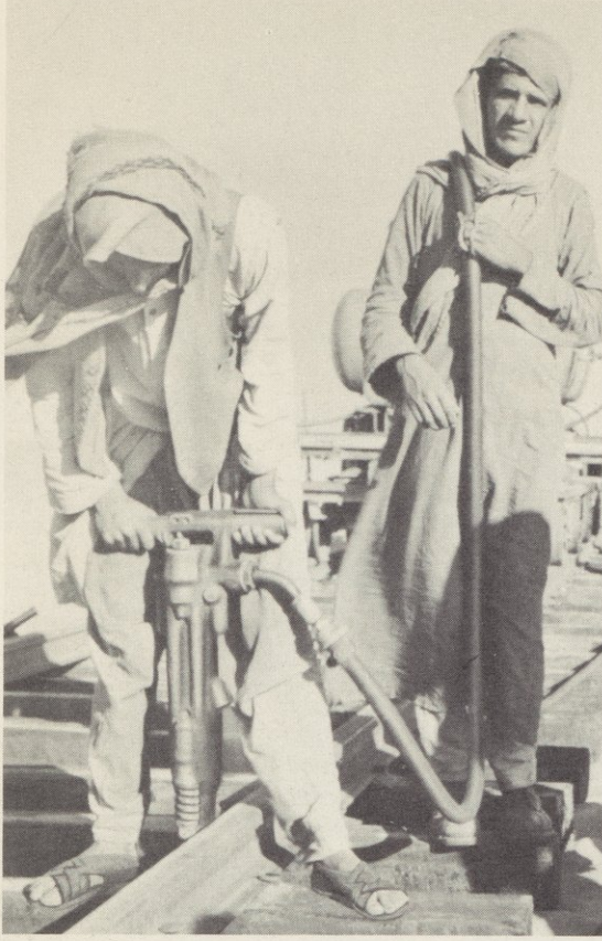
هنا يقوم العمال بدق النبلات في الاربطة الخشبية بواسطة ضغط المطرقة الهوائية ذات القوة الهائلة
