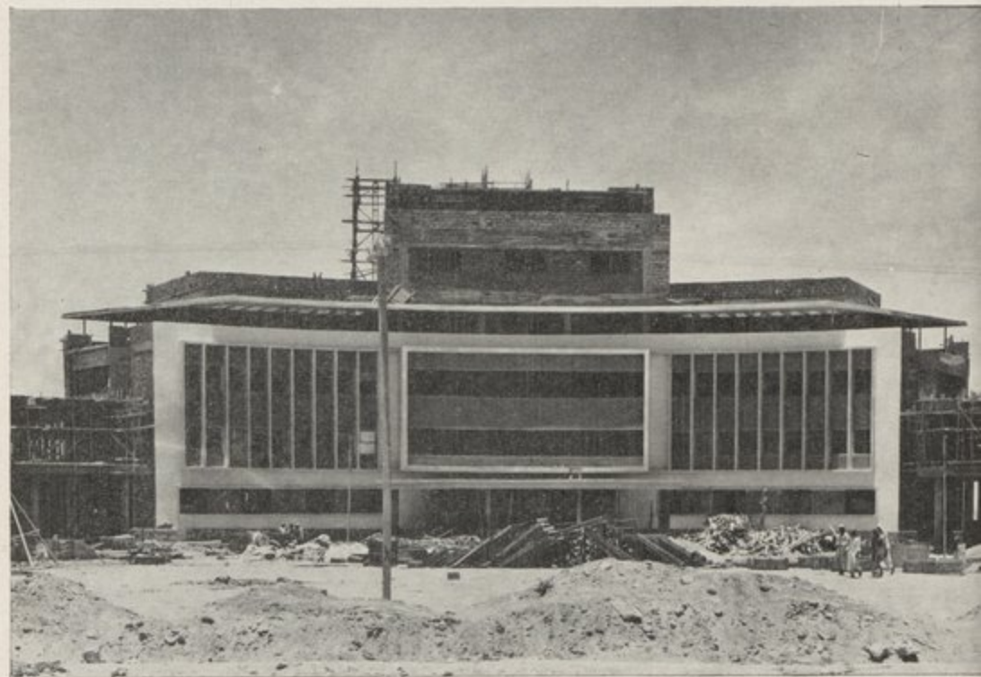
مبنى وزارة الصحة الجديد في الرياض
