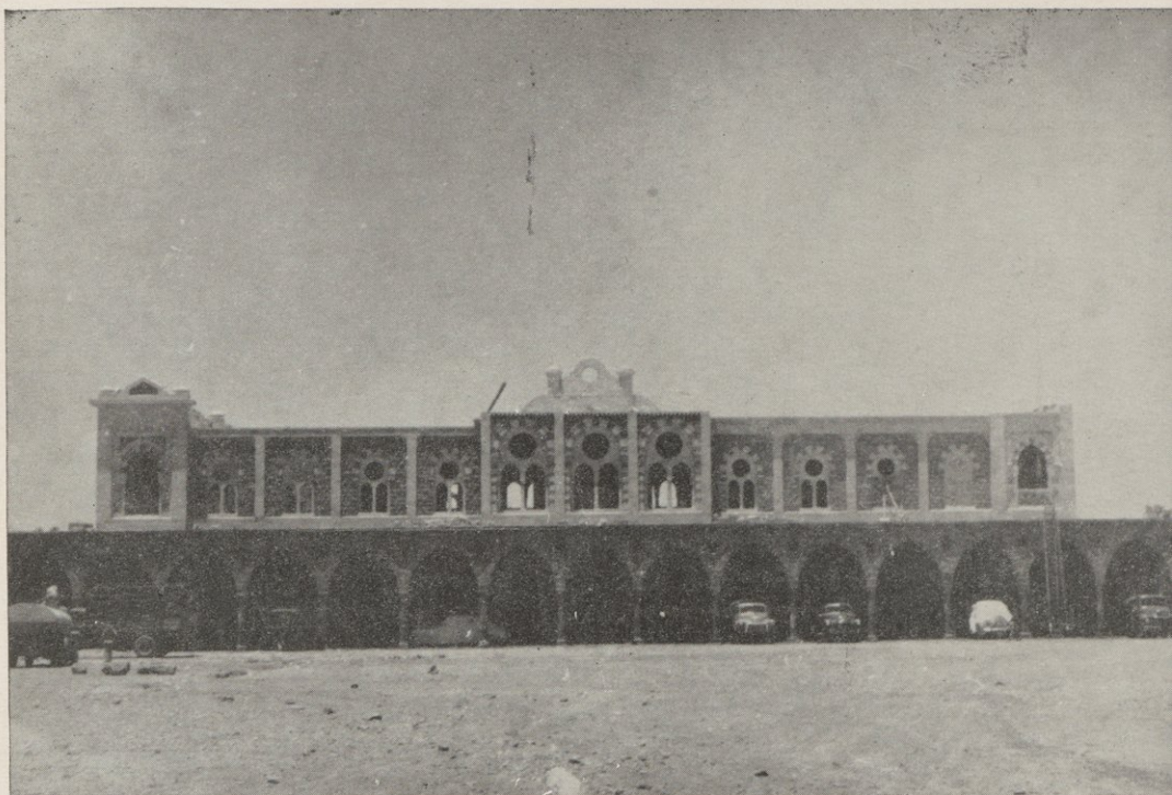
بناء محطة سكة حديد الحجاز بالمدينة المنورة
