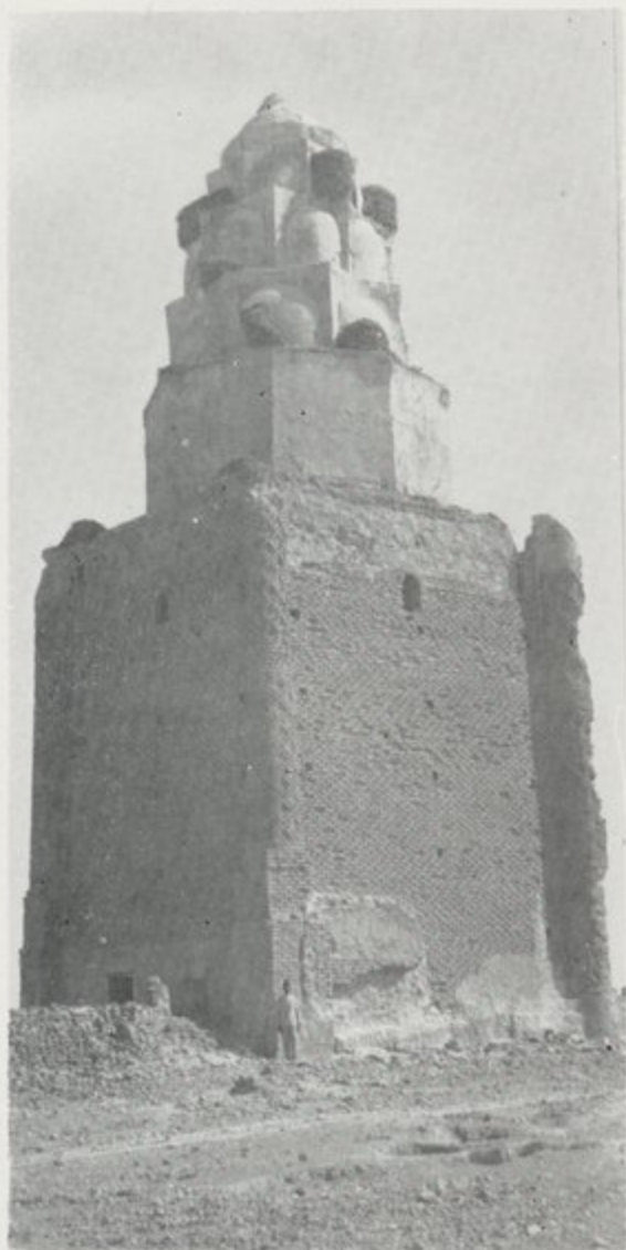
الشكل (٢٤) : مشهد امام الدور قبل أعمال الترميم
