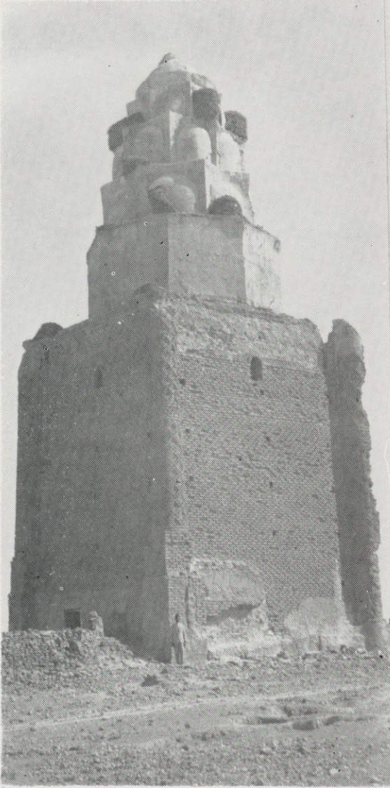
الشكل (٢٤) : مشهد امام الدور قبل أعمال الترميم
