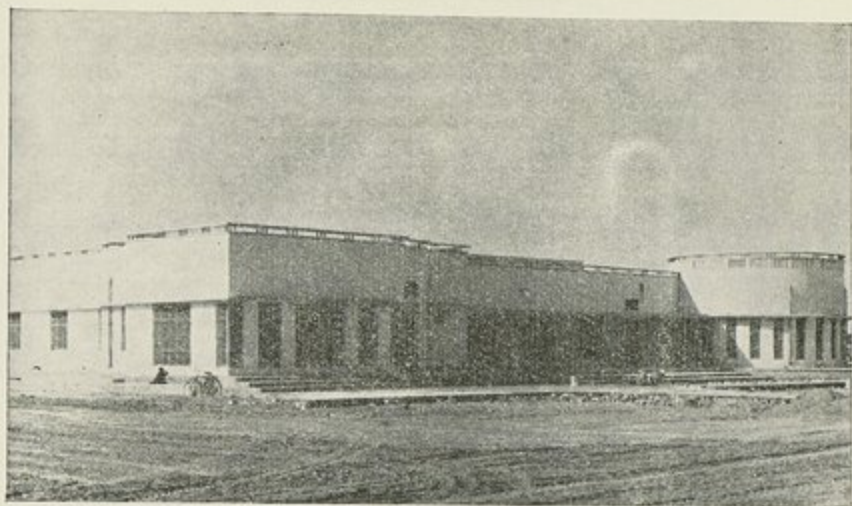
بعض المباني العامة التي تتولى بلدية العمارة انشاءها بموجب الخطط الرامية الى اعمار البلدة
