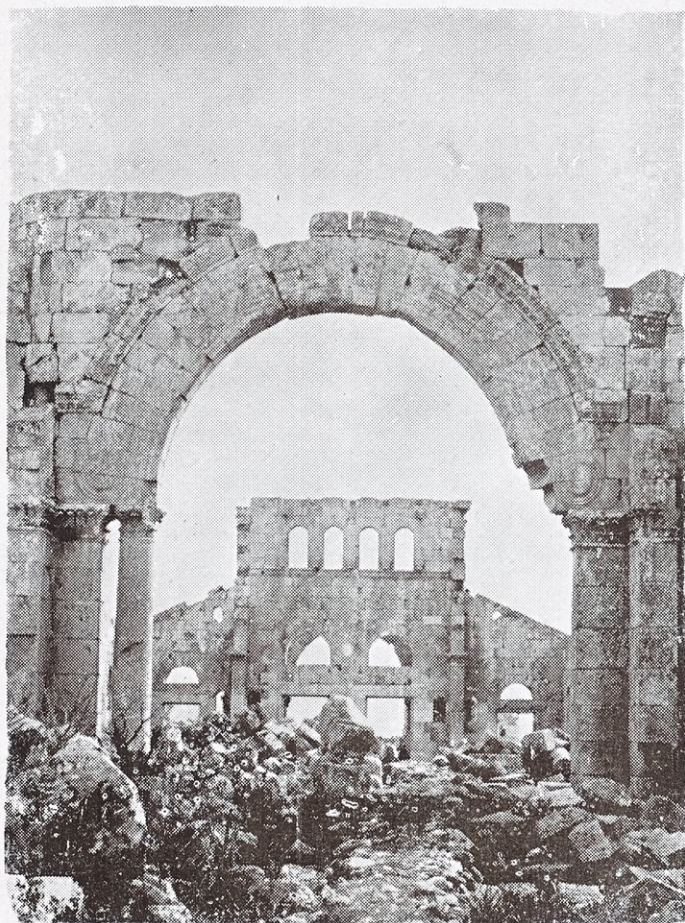
صورة رقم ٢٦ - المدخل الرئيسي للكنيسة ، من الخلف ، ويظهر فيه الفتحات فوق السواكف - ص ٤٤ - ستوديو الازهرام - نوبار شاهينيان
