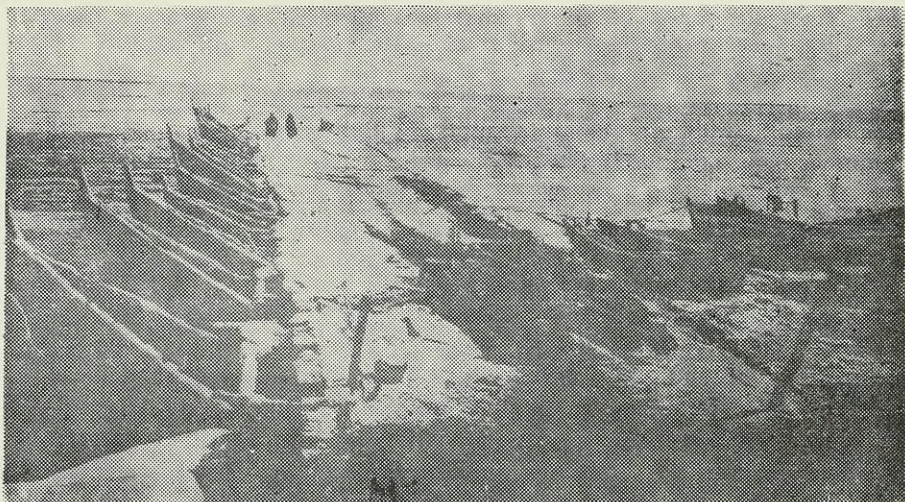
جسر الموصل الخشبي القديم
