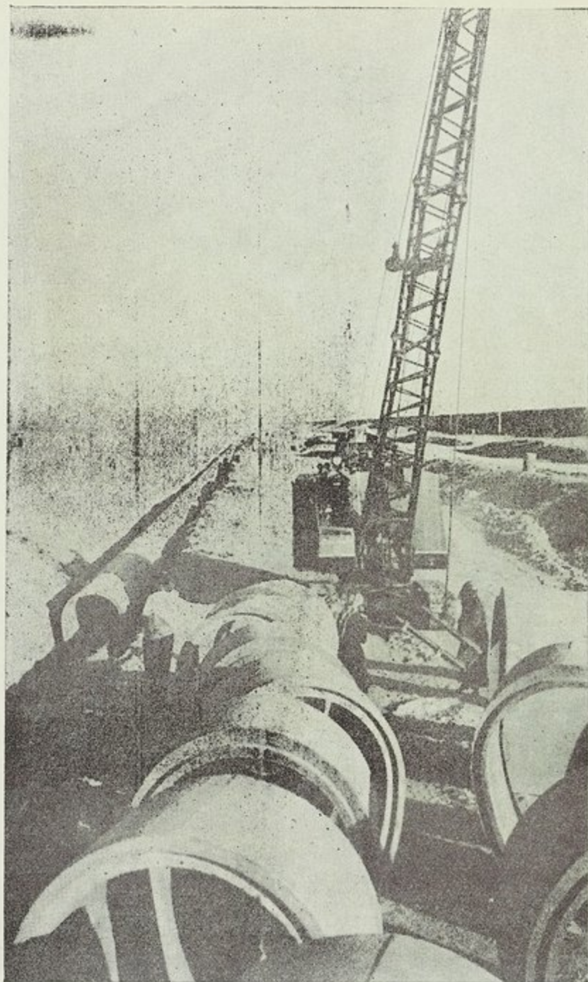
أعمال مد الانابيب الكونكريتية في مشروع القضاء على الشريط
