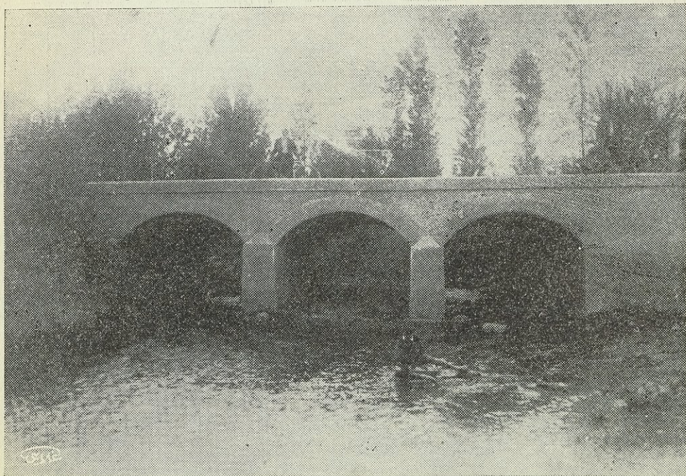
جسر على نهر الاعوج في موقع حوش مرانه وهو ذو ثلاث فتحات كل واحدة منها ثلاثة امتار
