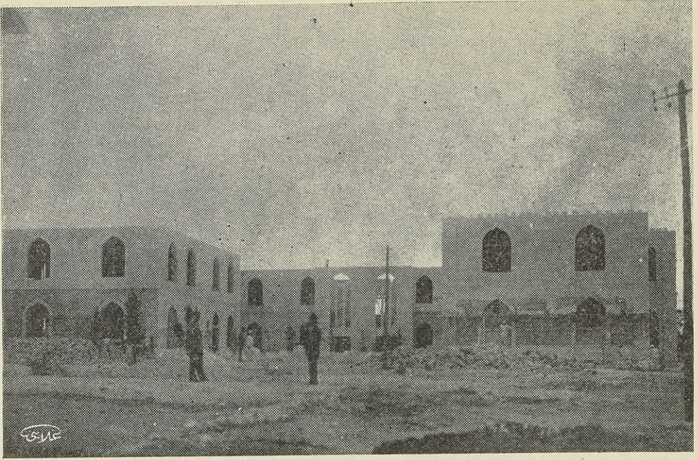
منظر الواجهة الجانبية لبناء دار المعلمين بحلب
