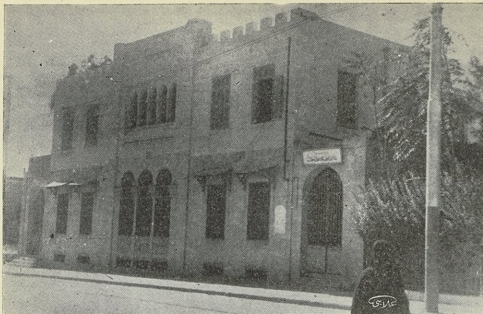
الخبير الكيماوي لمكافحة الغش فوق مستوصف مرعي باشا بجلب ( منظر الواجهة الامامية ) تبلغ مساحة البناء ٢٣٠ متراً مربعاً
