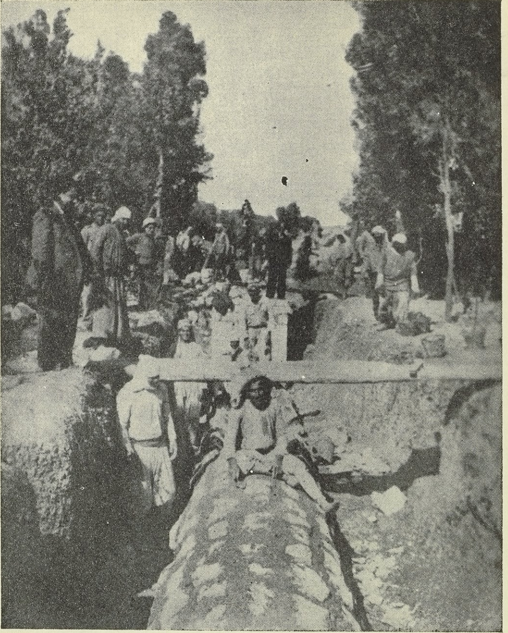
تحسين بناييع حيلان ورشة اكساء القناة بالبناء مع انشاء فوهات للتعزير
