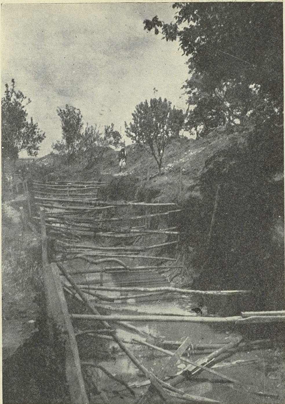
اعمال تحسين ينابيع حبلان ورشة حفریات قناة الاستجزار وقد بلغ عمقها في بعض الاقسام ما يزيد على الستة امتار
