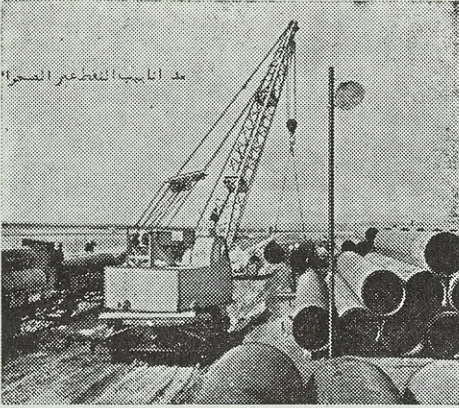
عملية مد انابيب النفط عبر الصحراء
