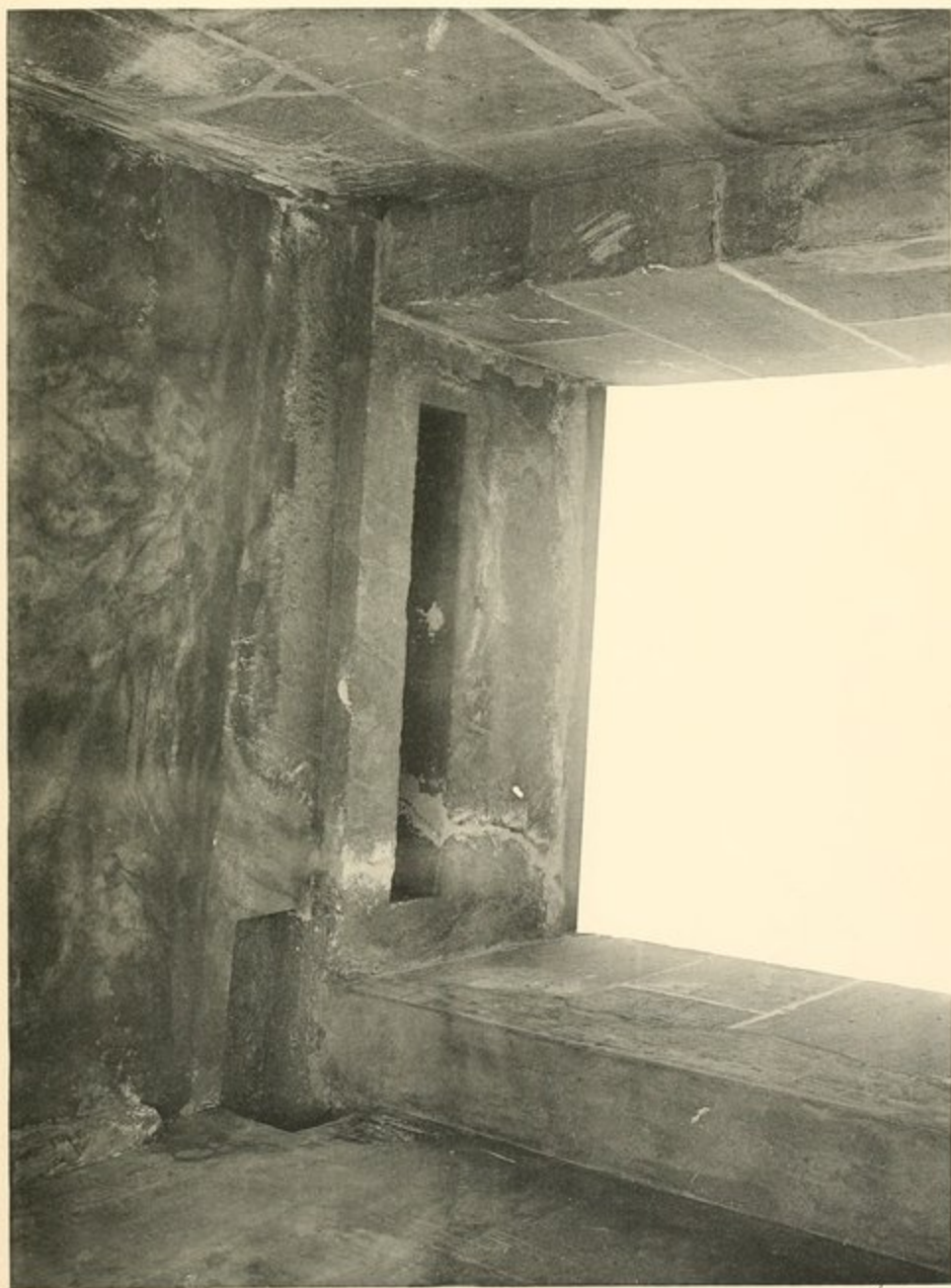
1. Pylon, Durchgang : Osthalte oben, von unten gesehen.
