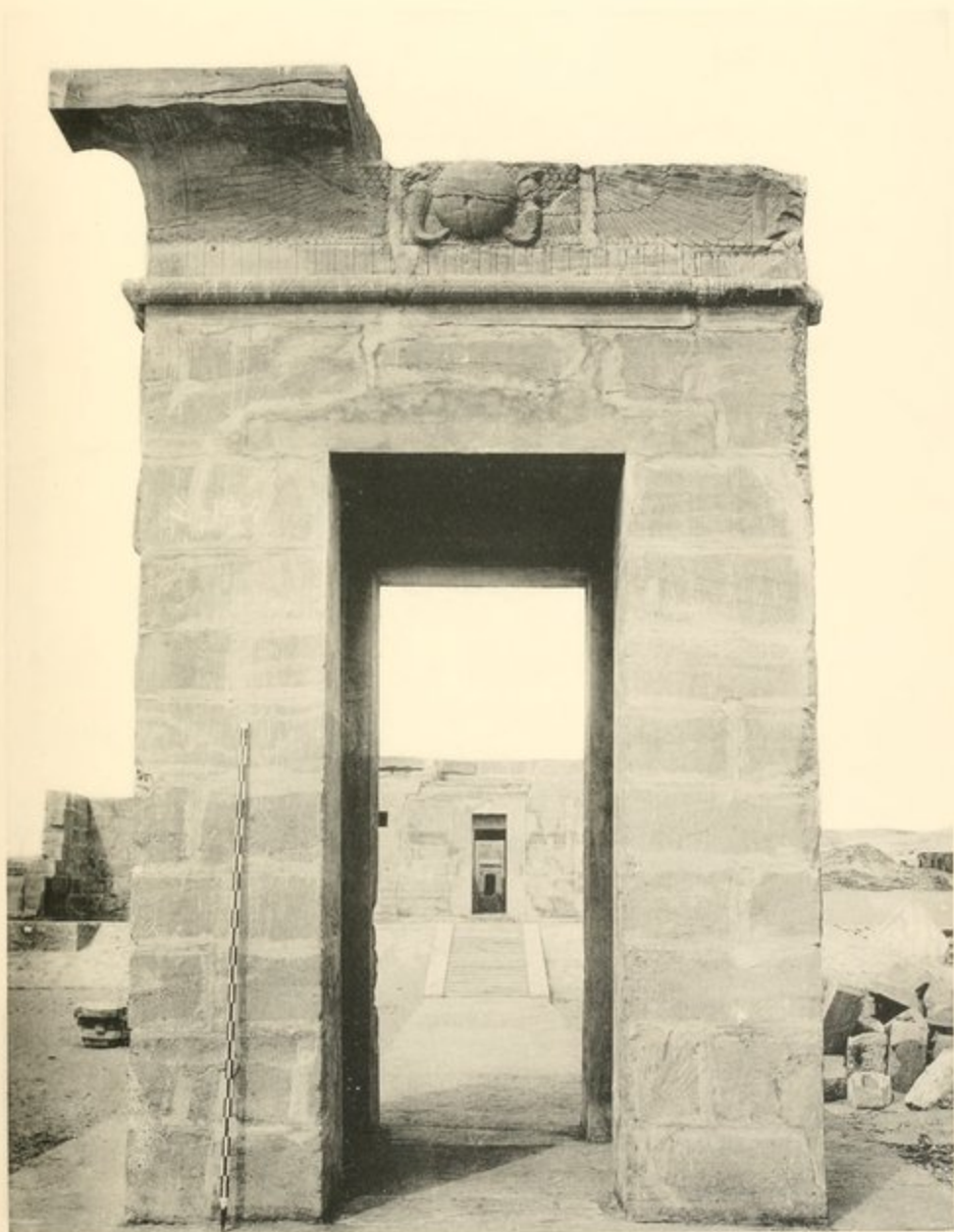
Der zweite Pylon von Osten.
