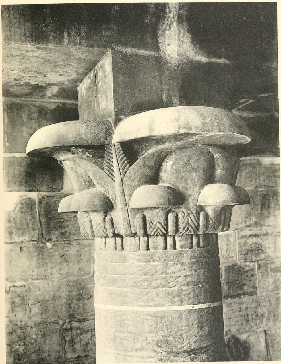
Kapitell der südwestlichen Säule, von Ost-Süd-Osten.
