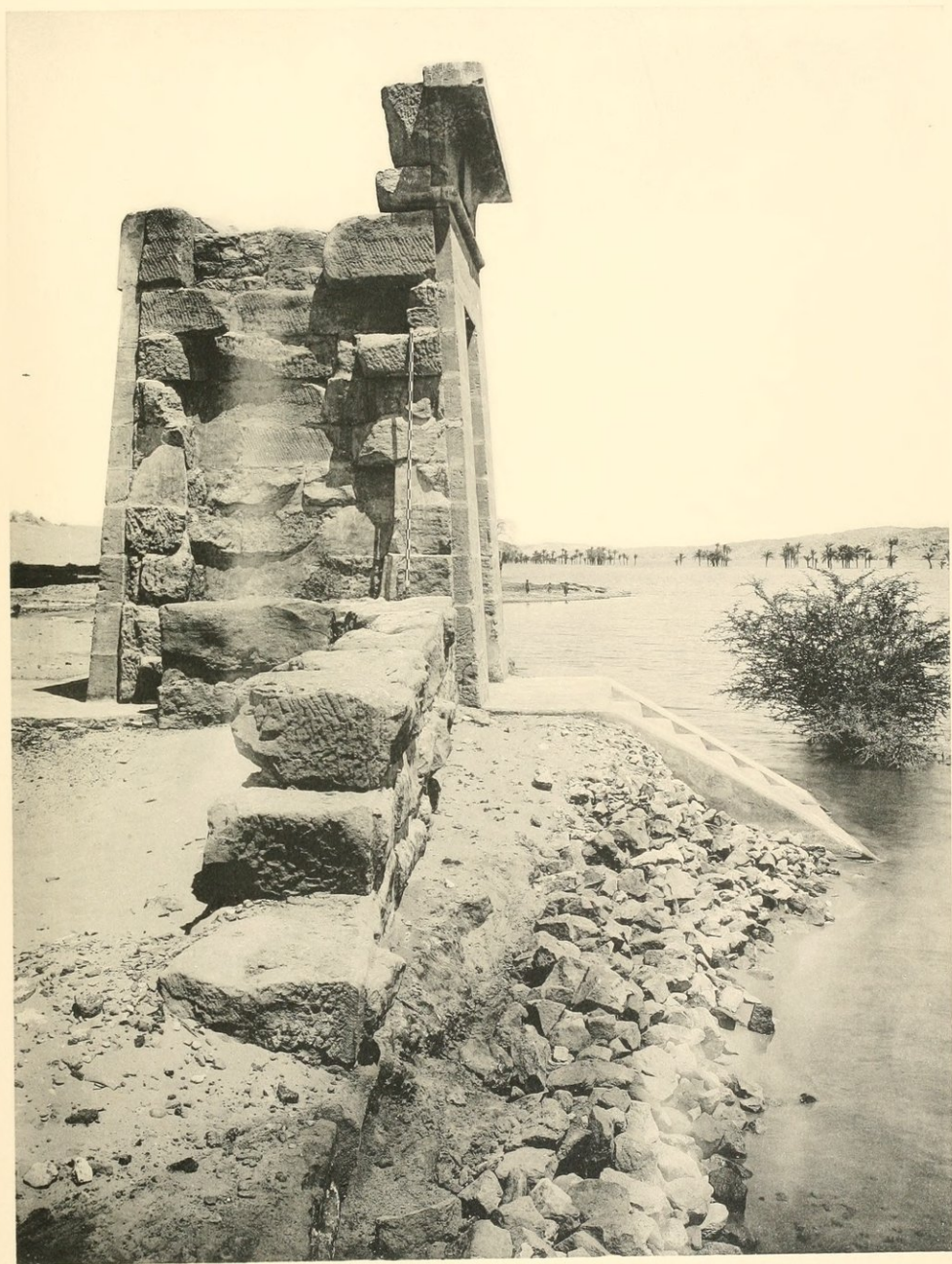
Der erste Pylon von Süden.
