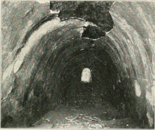
Fig. 4. Tiefe Kelleranlage, Länge 35 m. (Aufnahme von Reiser & Binder, Alex.)
