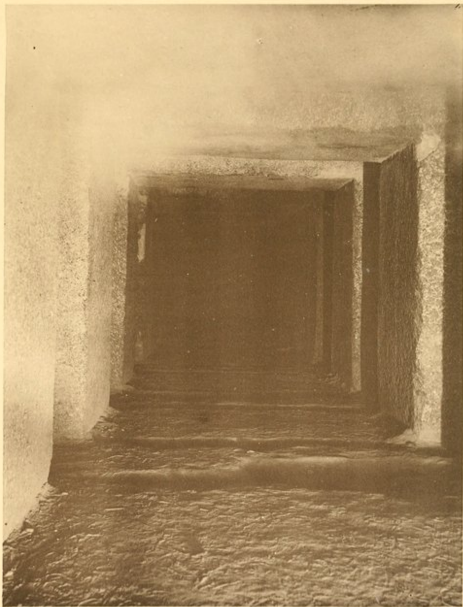
PYRAMIDE D'OUNAS. LE COULOIR D'ENTREE ET LES RAINURES DES HERSES EN GRANIT.
