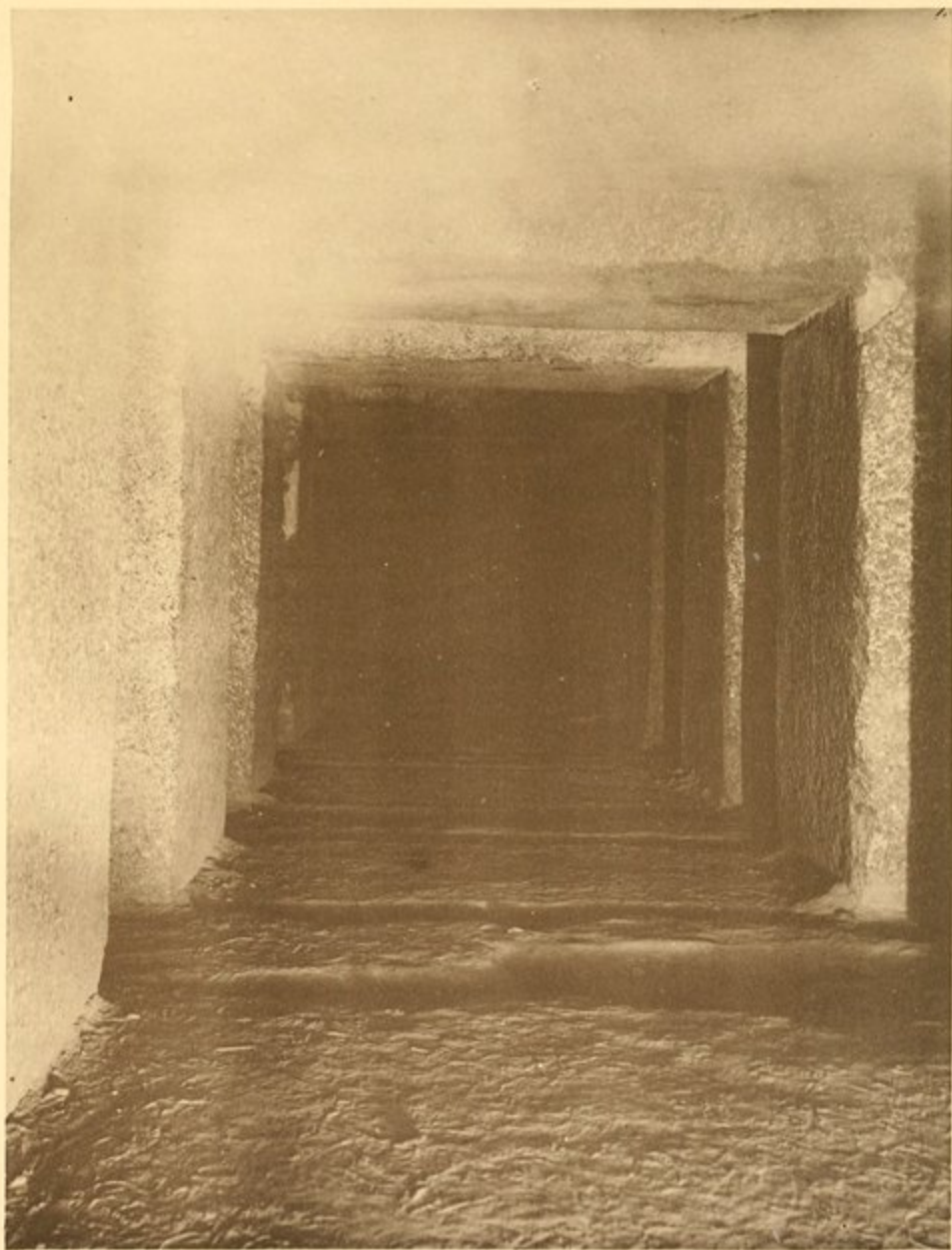
PYRAMIDE D'OUNAS. LE COULOIR D'ENTRÉE ET LES RAINURES DES HERSES EN GRANIT.
