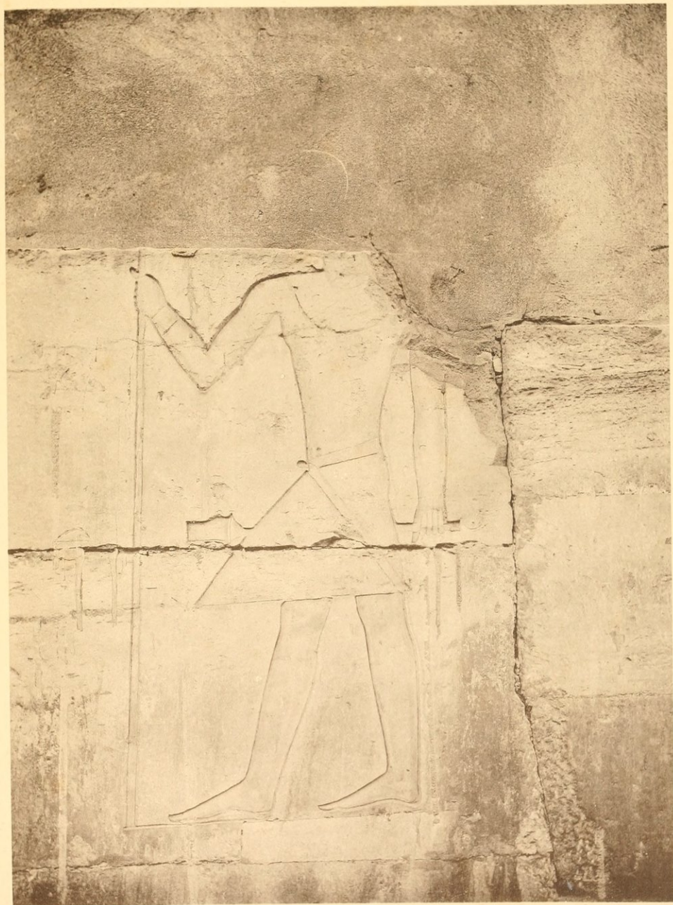
FAÇADE DU MASTALA ENTRE LES TOMBEAUX DE ANKH-MA-HOR ET DE NÉFER-SESHEM-PTAH.
