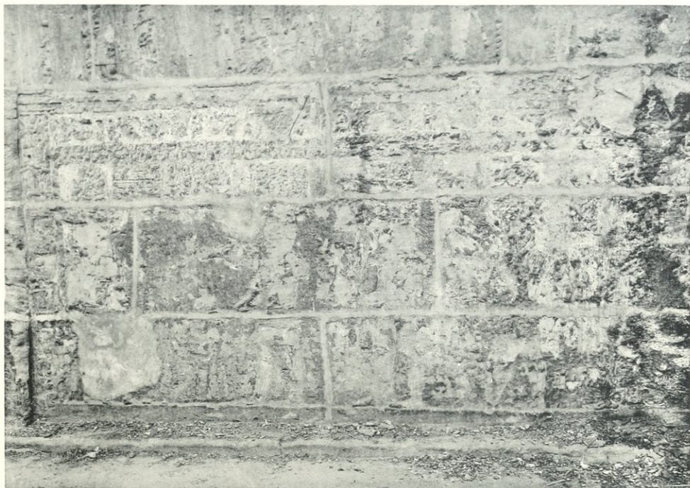
A). — Pronaos. Paroi ouest. Aile nord. Soubassement. Moitié de gauche.
