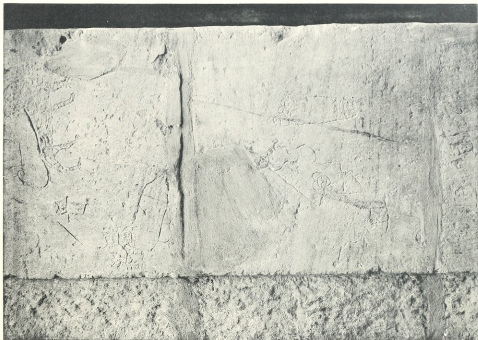
B). — Montant gauche de la même porte.
