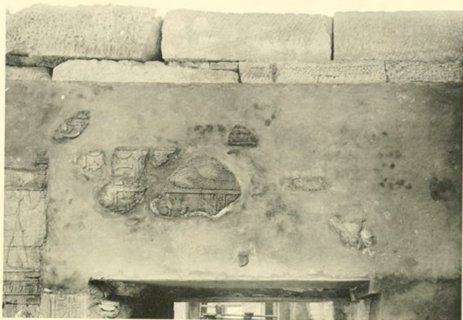
A). — Porte de la Cella. Linteau intérieur.
