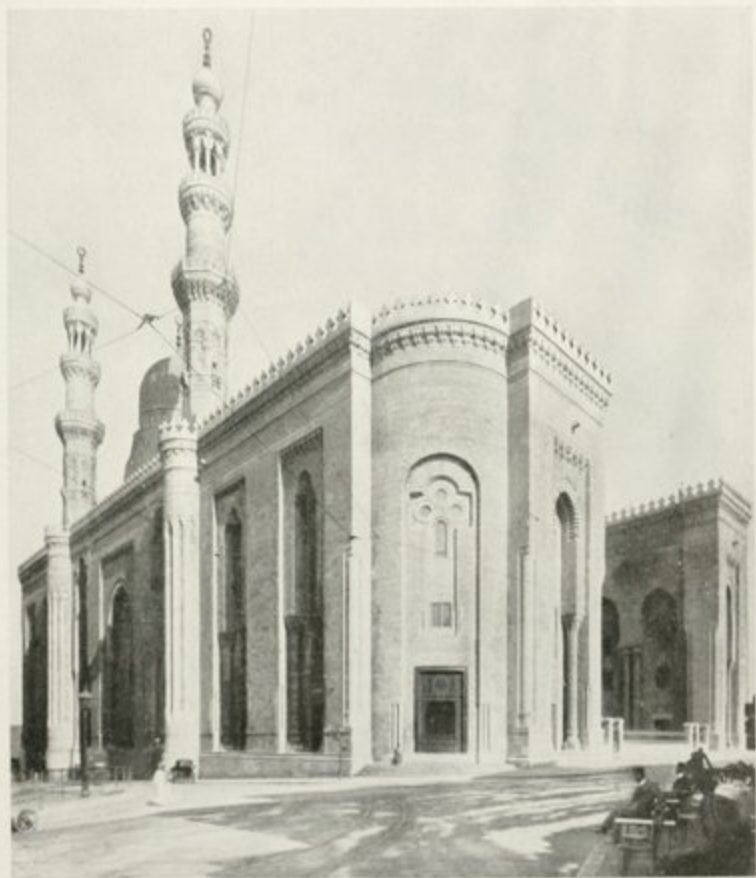
Pl. XIV. — Façade sud et ouest après achèvement des travaux en 1911.
