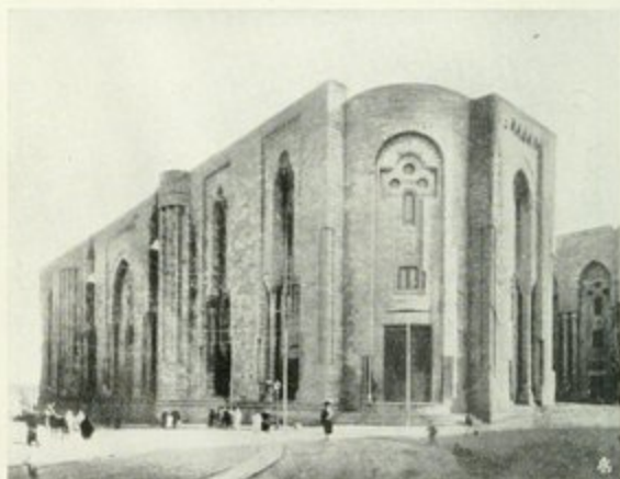
Fig. 8. — Vue des façades sud et est avant la reprise des travaux en 1906.
