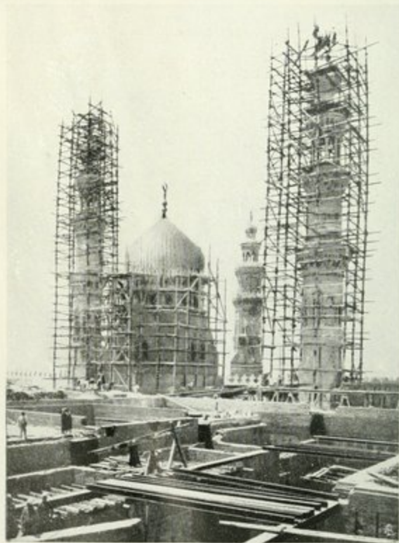
Fig. 14. — Vue du chantier lors de la construction des minarets et de la coupole sud.
