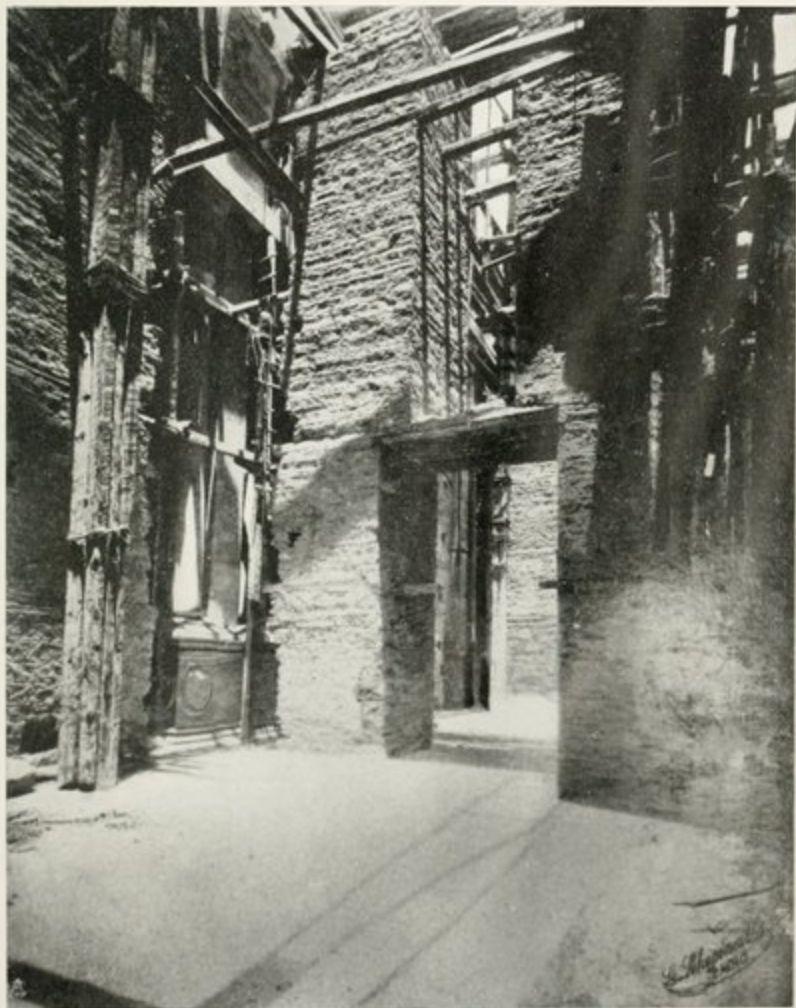
PL. XI. — Vue intérieure de la grande salle de prières en 1906. (La figure fait voir les piliers en maçonnerie grossière qui servaient de cintrage pour la confection des arcs).
