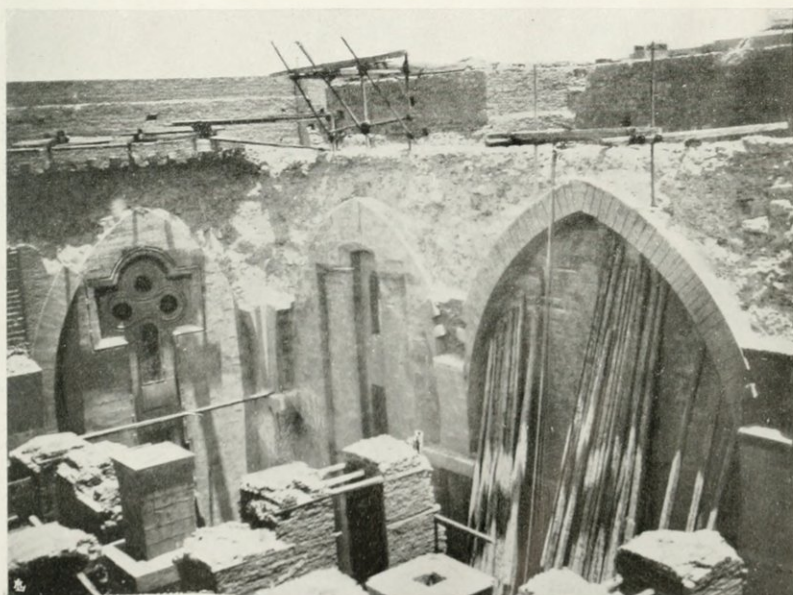
Fig. 6. — Vue des arcs accolés aux murailles pendant leur démolition. (Le cliché laisse voir en A la naissance des arcs prévus seulement sur le pilier central).
