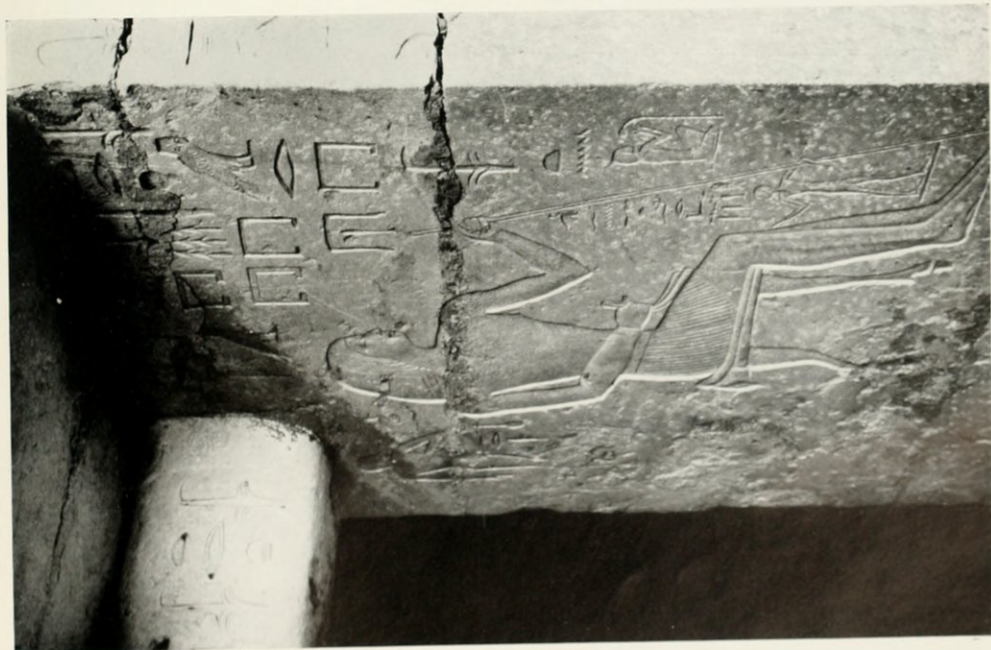
a) nördliches Türgewände
