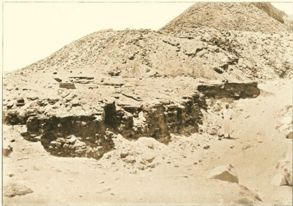
Tranchée au nord de la pyramide. — 15 Mars.
