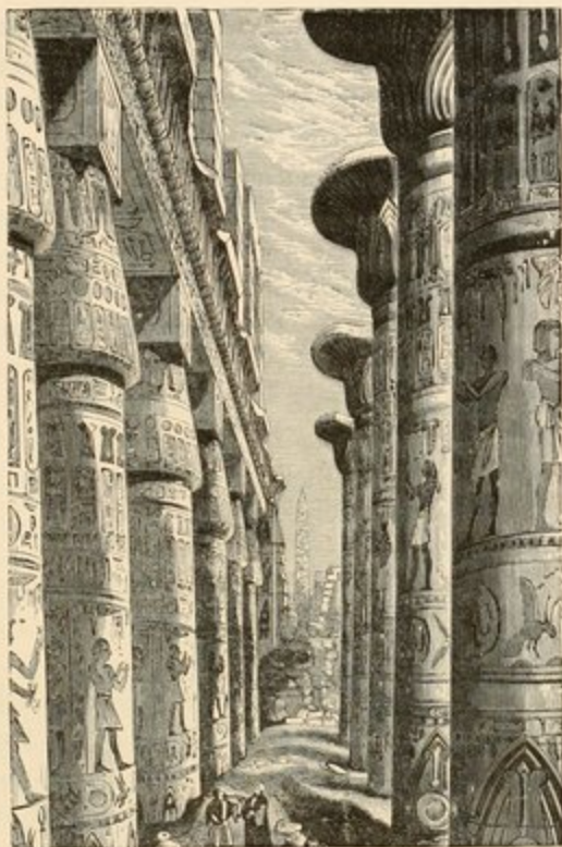
Fig. 7. Hall of Columns, Karnak.
