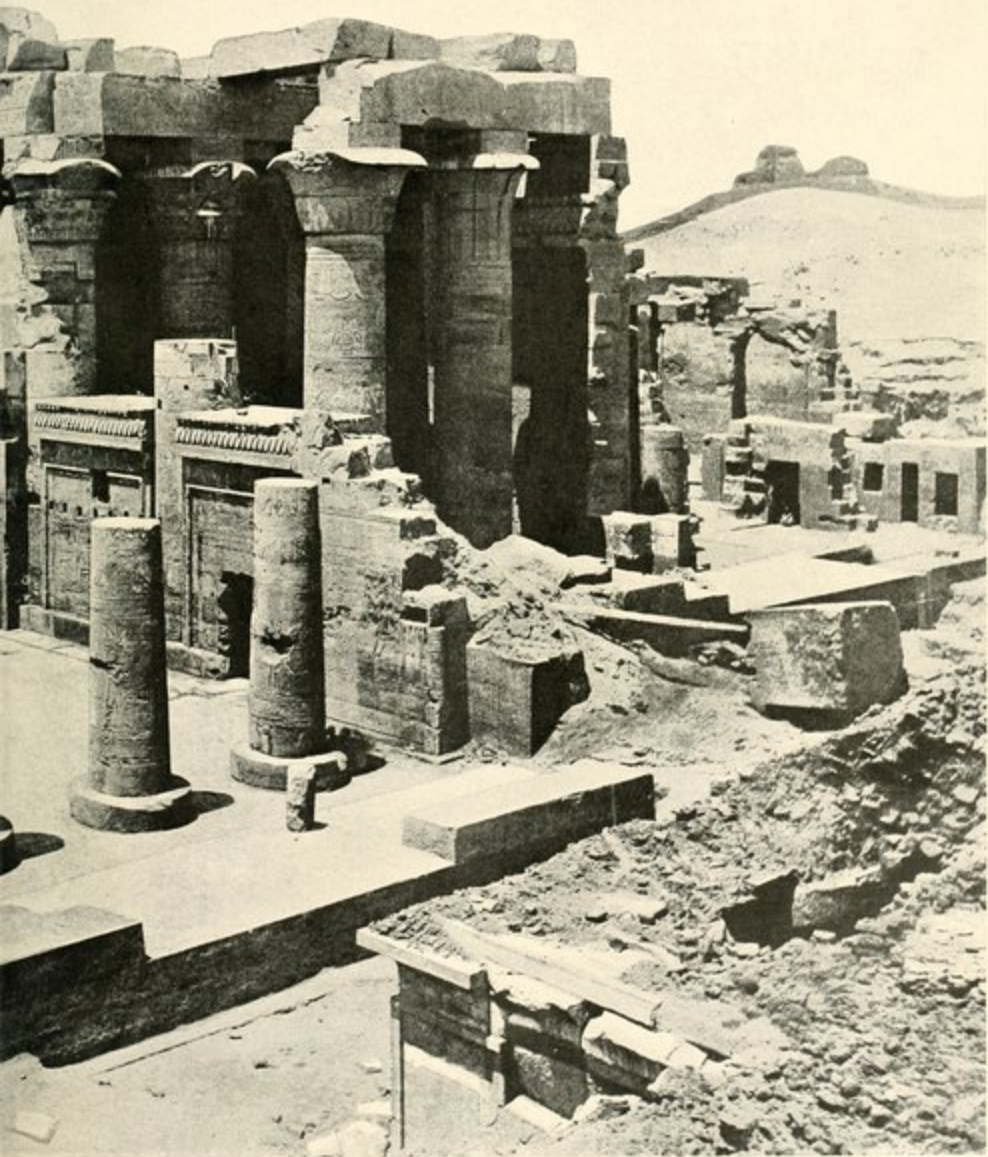
APRÈS LE DÉBLAIEMENT.
