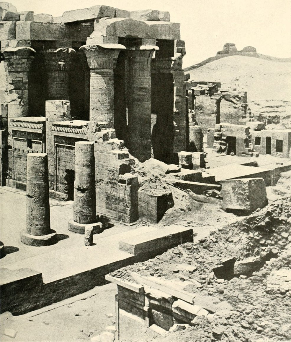
APRÈS LE DÉBLAIEMENT.
