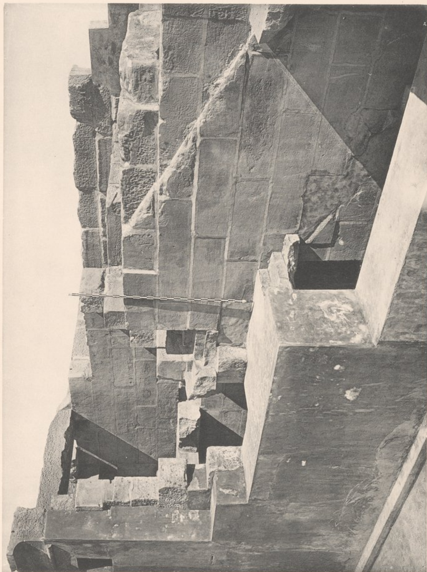
Treppe zum Dach, von Südosten.
