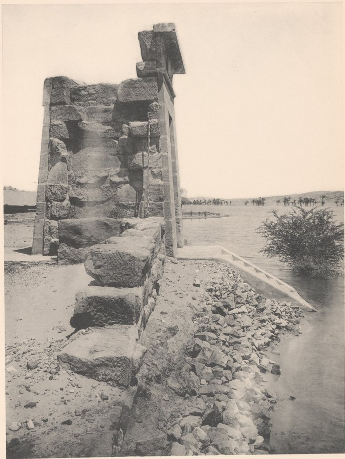
Der erste Pylon von Süden.
