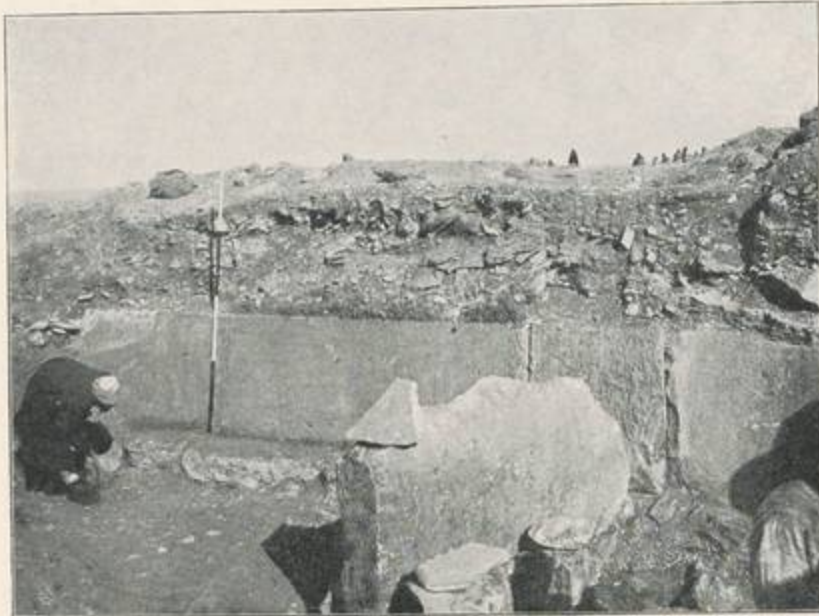
Abb. 43. Rest der äusseren Bekleidung der Westmauer, davor ein Deckblock der Mauer.
