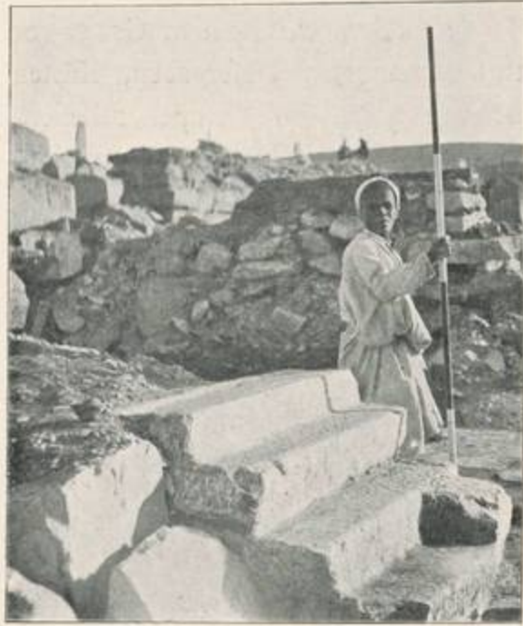
Abb. 30. Rest der Treppe im Magazingebäude, von N gesehen.
