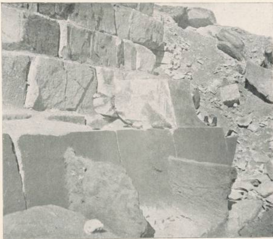
Abb. 25. Bekleidung aus Granit und weissem Kalkstein vor dem Kernmauerwerk aus gelbem Kalkstein auf der Ostseite des Obeliskenunderbaus.
