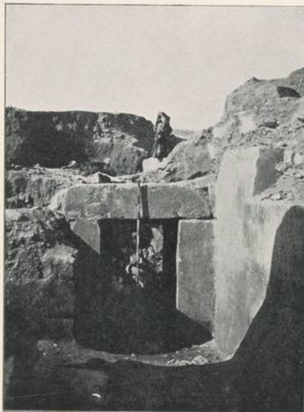
Abb. 6. Tür zum Treppenhaus im Torbau im Tale, von O. gesehen.
