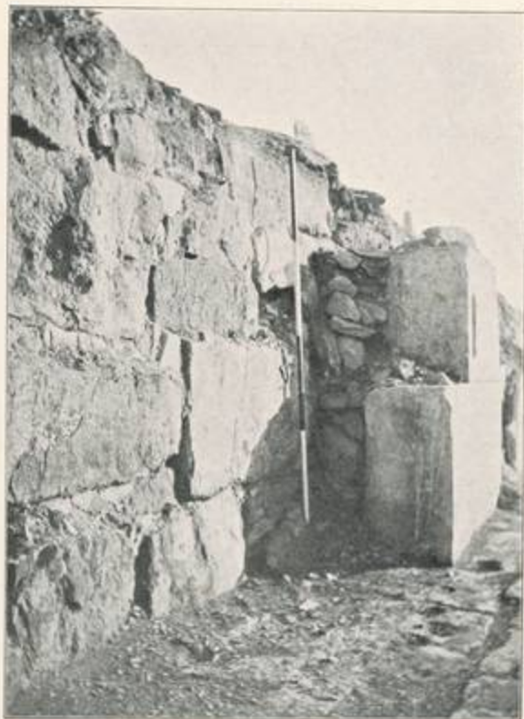
Abb. 17. Stück der Innenseite der Ostmauer des südlichen Umgangs.
