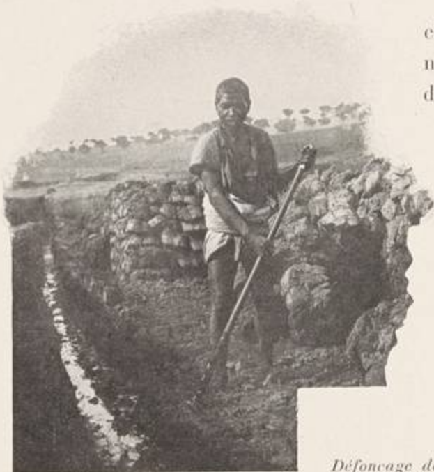
Défonçage de la rizière.
