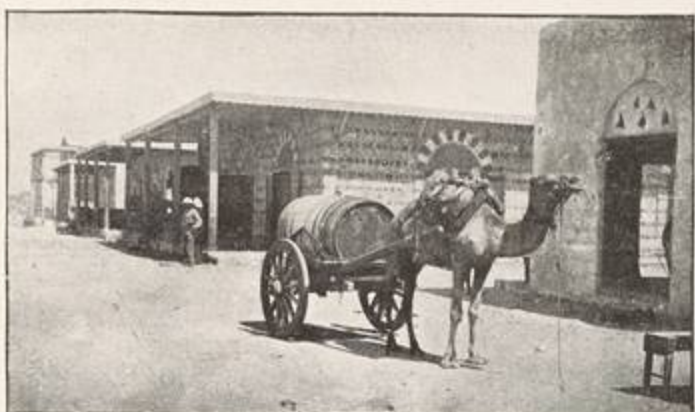
L'eau potable à Djibouti, le service à domicile.
