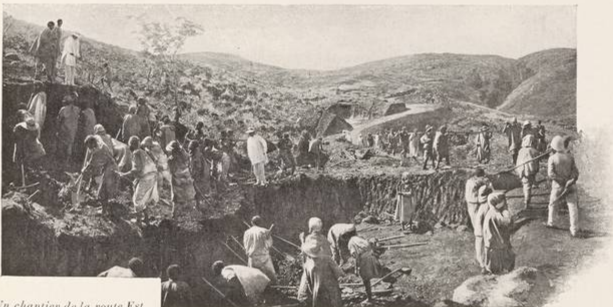
Un chantier de la route Est.
