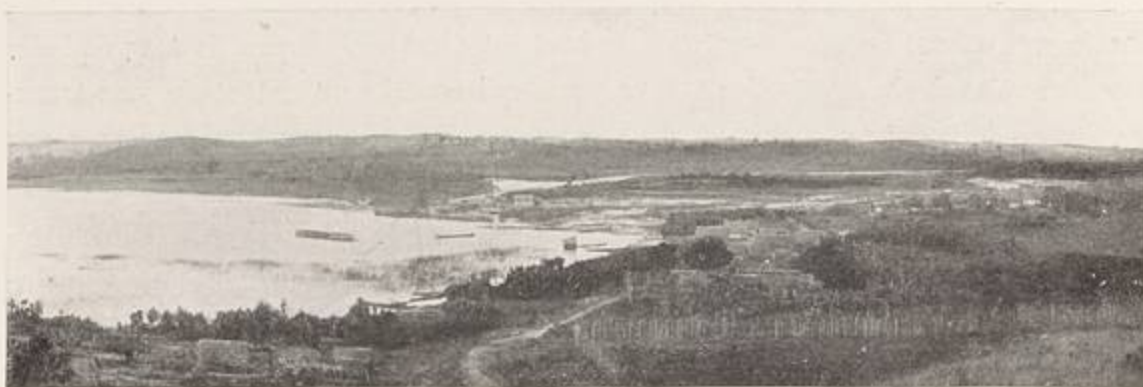
Les Pangalanes; le canal en voie de percement à Tanifotsy.
