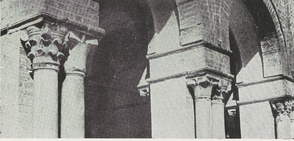
(شكل ٢٦) تيجان من المحنبة الغربية قد يرجع تاريخها إلى عهد بني حفص في آخر القرن السابع الهجري
