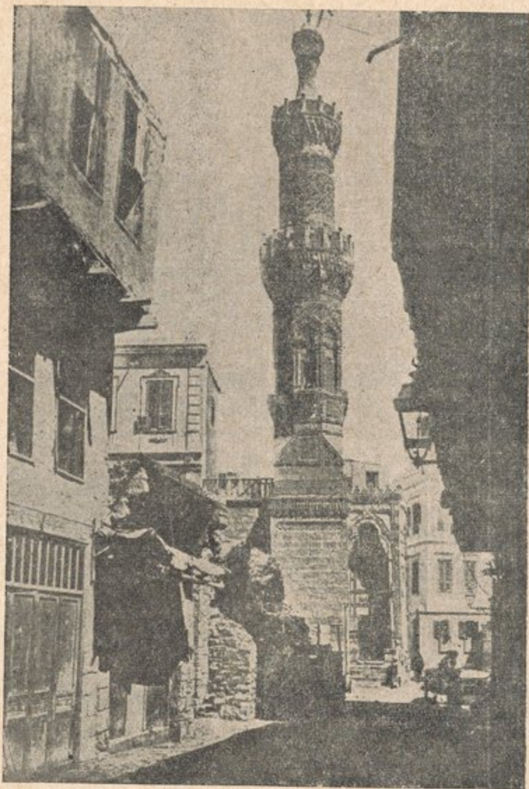
(شكل ٨٥) مسجد البرديني بشارع الداودية (١٦١٦ - ٢٩ م)
