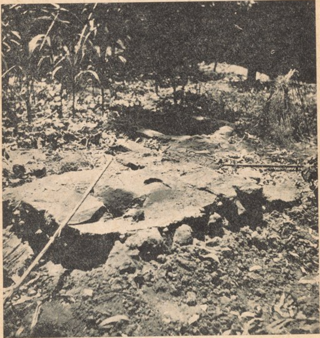
الصورة رقم ١٨ — مرايض المجرور ( البلدى ) ويظهر مكان التبرز فى الجزء الأمامى من الصورة وإلى الخلف توجد البيرة التى تصرف إليها الحمأة .
