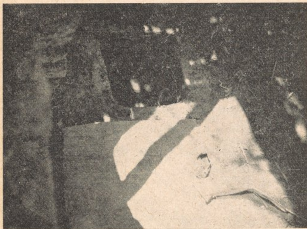
الصورة رقم ١٩ - حوض صغير مبنى من تراب مثبت بالأسمنت و بياض الأسمنت لا يتسرب منه الماء .
