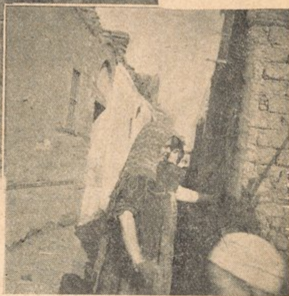
الصورتان رقم ٣٠ ، ٣١ نساء قرية قلتي الكبرى أثناء قيامهن بلباسة الجدران الخارجية للمساكن ببياض من الطين قبل طلاستها بالجير الأبيض .
