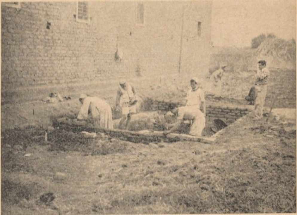
الصورة رقم ٨ - بناء حفرة للسجاد خلف حظيرة الحيوانات (الزربية) بقرية فيشا الصغرى .
