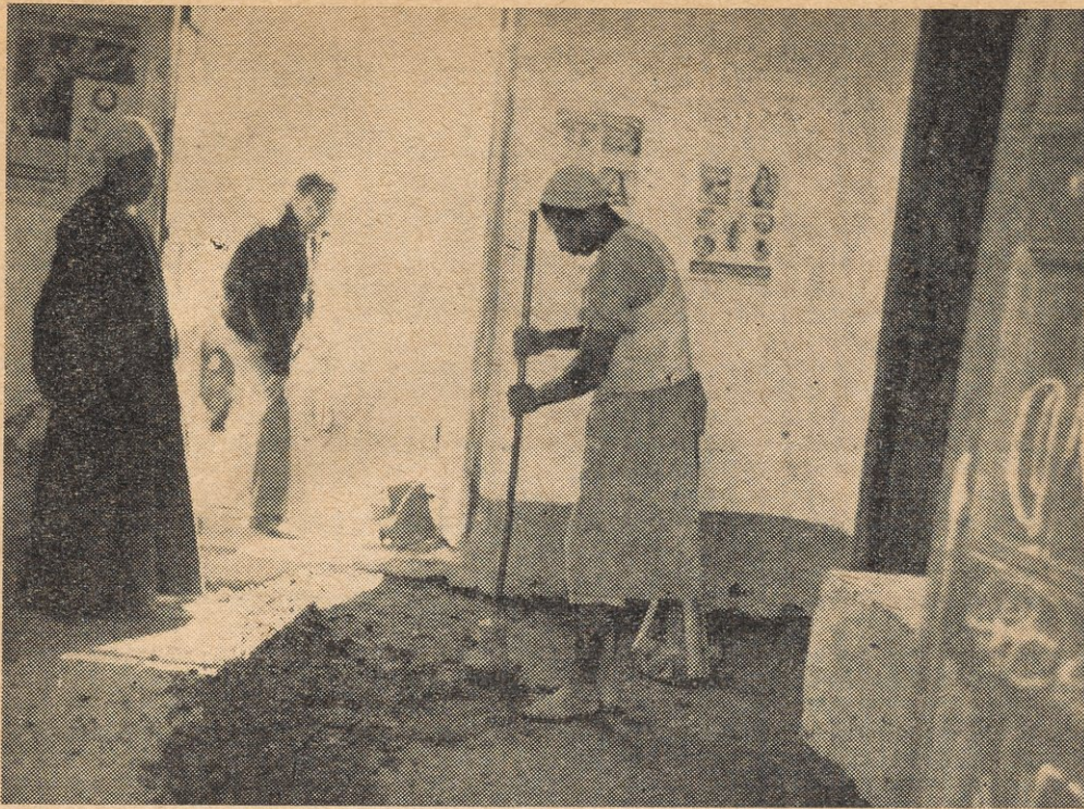
الصورة رقم ٧ - أرضية محسنة مصنوعة من خليط التربة والأسمنت المسبى (landcrete) بقرية دبركي بمديرية المنوفية .
