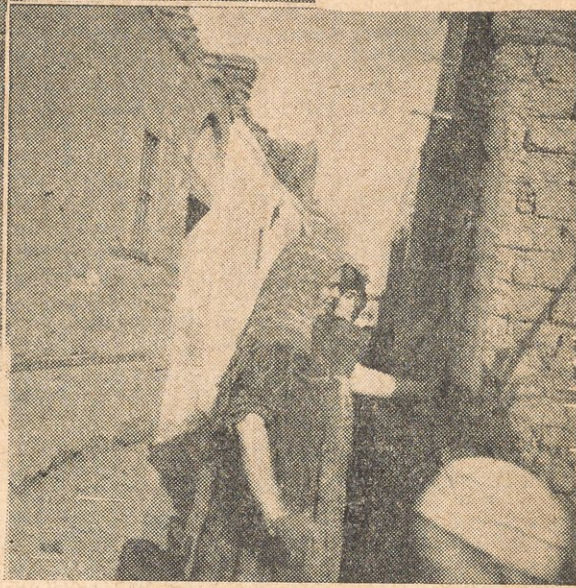
الصورتان رقم ٣٠ ، ٣١ نساء قرية قلتي الكبرى أثناء قيامهن بلباسة الجدران الخارجية للمساكن بمياض من الطين قبل طلاستها بالجير الأبيض .
