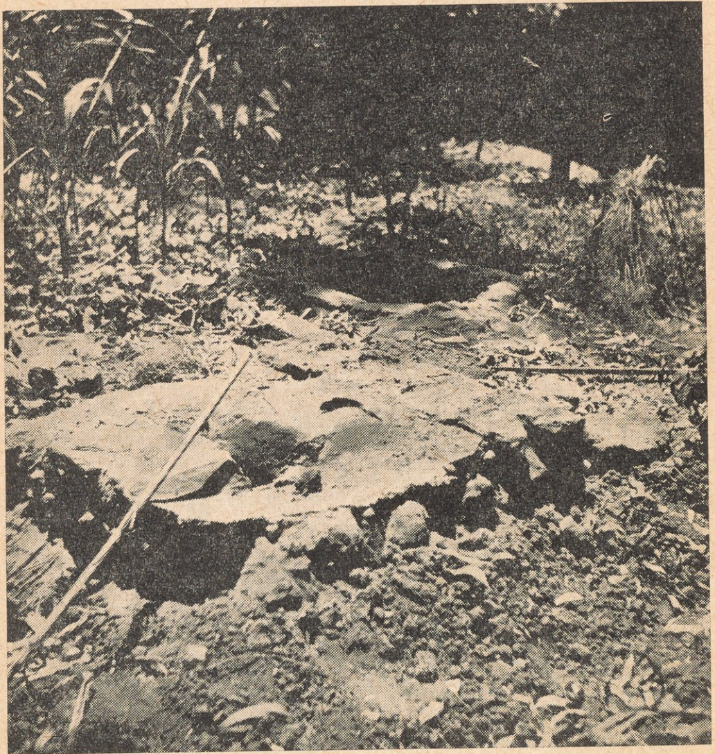
الصورة رقم ١٨ - مراض الحور ( البلدى ) ويظهر مكان التبرز في الجزء الأمامى من الصورة وإلى الخلف توجد البيرة التي تصرف إليها الحمأة .
