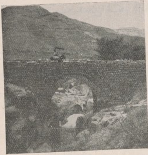
أحد الجسور المبنية من الاحجار المرصوفة بعضها فوق بعض بدون طين أو ما أشبهه وقد عبرنا فوقه في مرحلتنا الى السيانى
