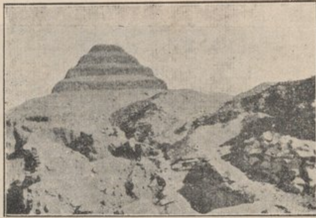
شكل (٥) الهرم المدرج بسقارة
