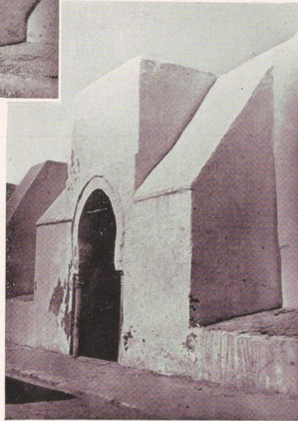
(شكل ٥٢) المدخل الثاني من الواجهة الغربية
