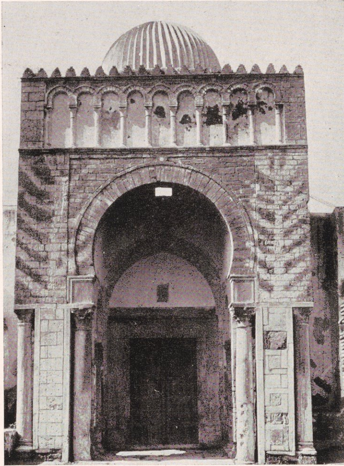
(شكل ٤٠) مدخل للآريخانا على الواجهة الشرقية
