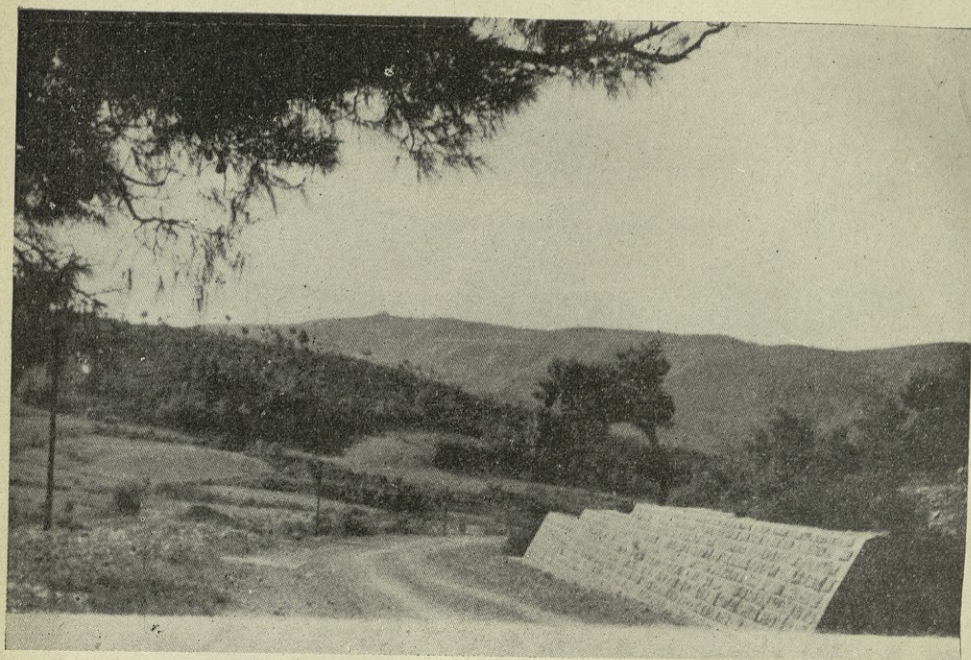
منظر الجدار الاستنادي الذي تم بناؤه على طريق اللاذقية انطاكية على طول ٤٠ متر في الموقع الكيلومتری ٤٤.
