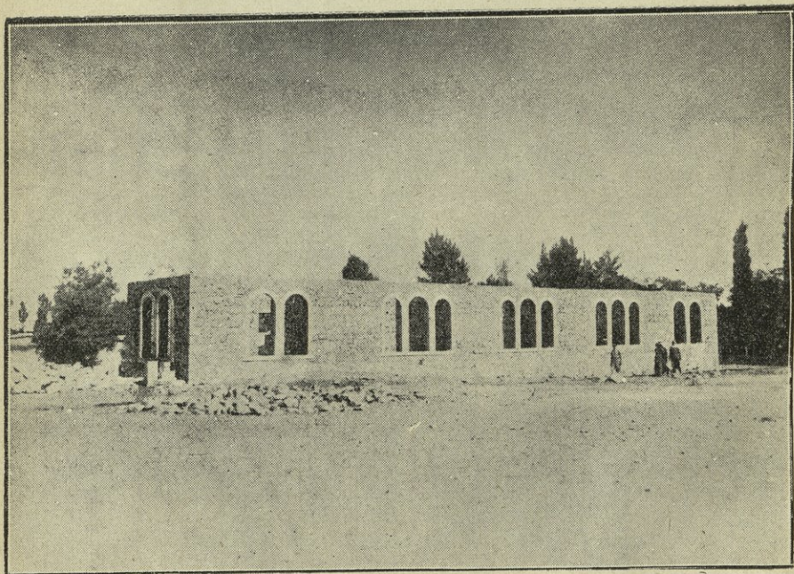
منظر مدرسة داريا اثناء البناء
