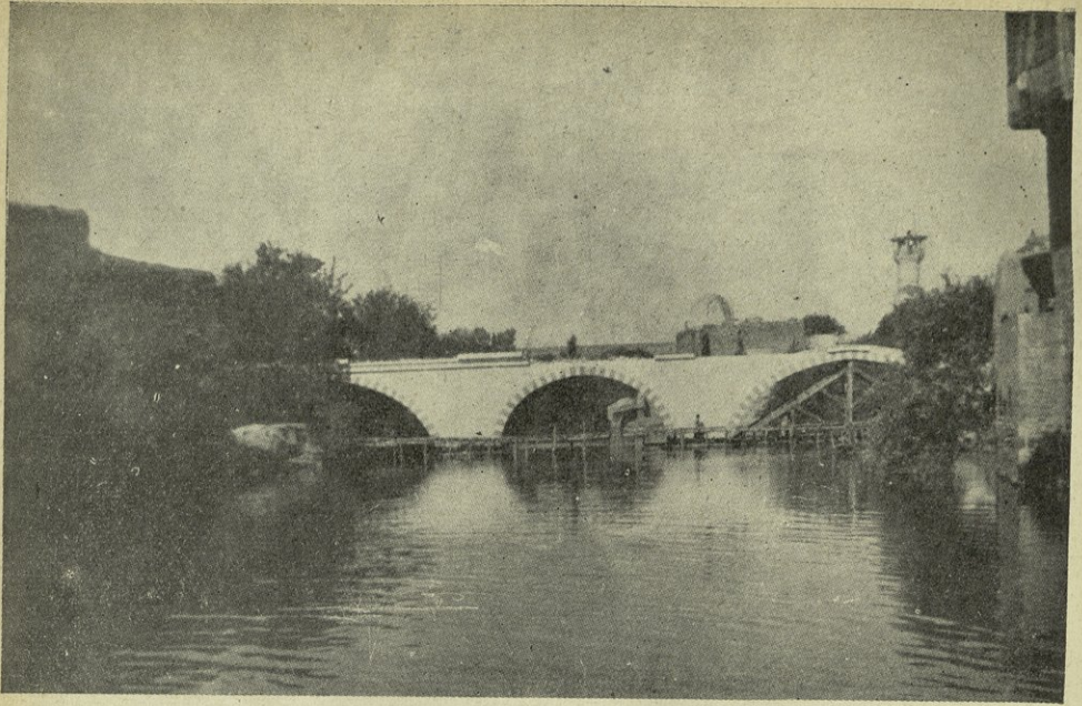
منظر جسر الهواء على العاصي وقد تم انشاء هذا الجسر بدلا من الجسر الذي هدمته السيول خلال شتاء عام ١٩٤٣-١٩٤٤ وهو بثلاث فتحات: الفتحة الوسطى مقدارها عشرة امتار والفتحات الجانبية بثلاثة عشر متراً
