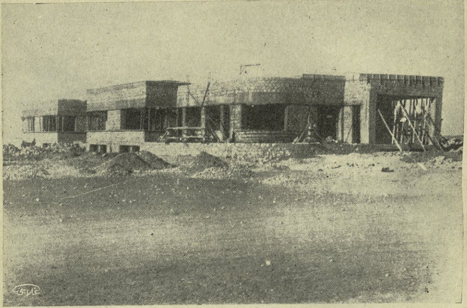
مستشفى القامشي - منظر احدى زوايا البناء
