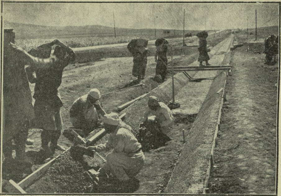
مشروع ري حمص وحماه - القناة الثانوية رقم ٩ التي تسيّر بجذاء الطريق العام من قرية أيو حتى حماه وتروي ١٤٠٠ هكتار ( اعمال اكساء البيتون لقاع القناة وجدرانها )
