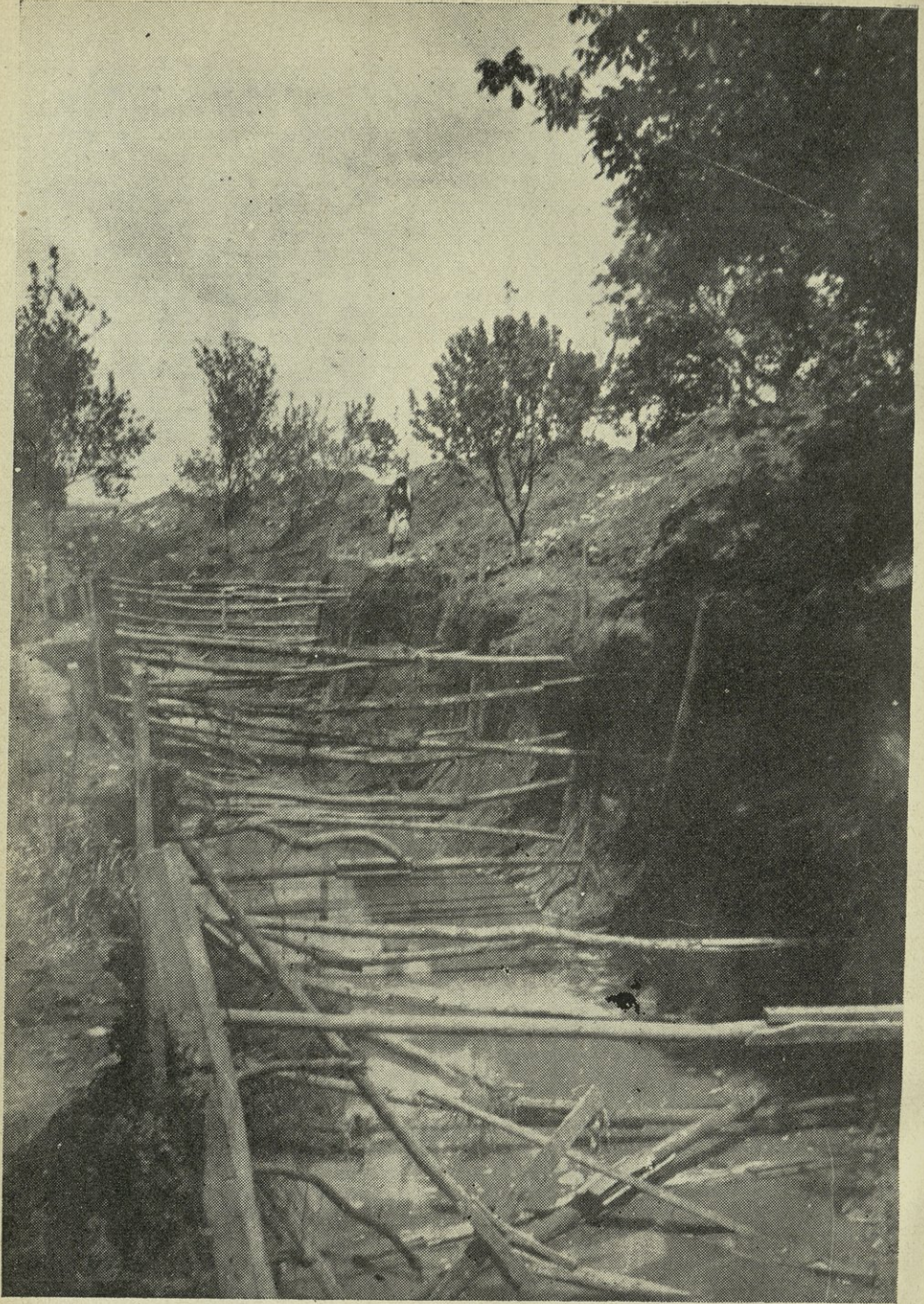
اعمال تحسين ينابيع حيلان ورشة حفریات قناة الاستجرار وقد بلغ عمقها في بعض الاقسام ما يزيد على الستة امتار
