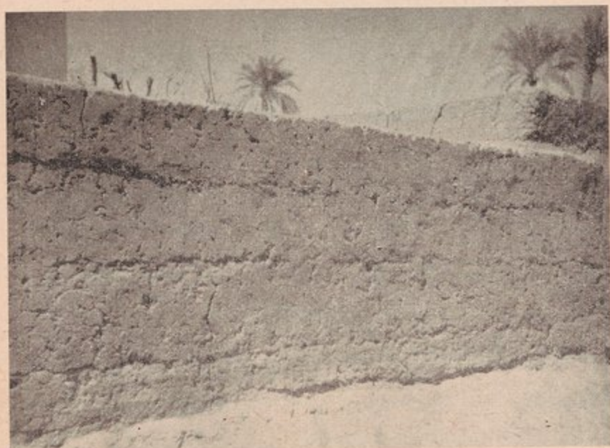
الصورة رقم ٦ - سور مبنى من الطوف (وهو خليط من الرمل والطين) في إحدى قرى مديرية الشرقية .
