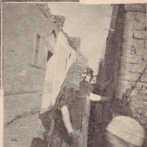
الصورتان رقم ٣٠ ٣١ نساء قرية قلتي الكبرى أثناء قيامهن بلباسه الجدران الخارجية للمساكن ببياض من الطين قبل طلاستها بالجير الأبيض .
