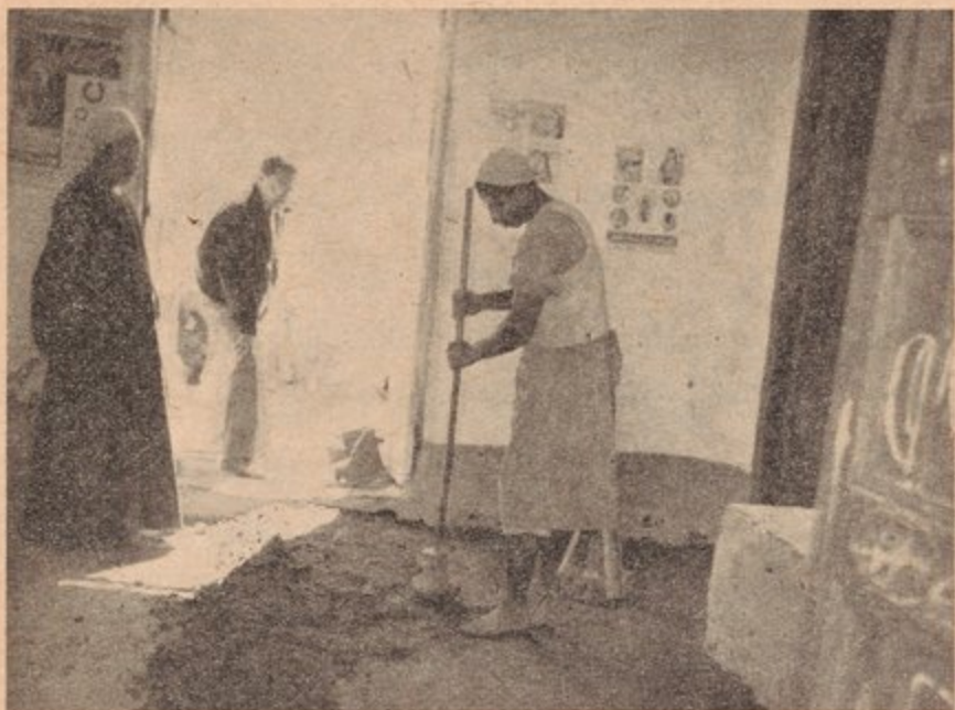
الصورة رقم ٧ - أرضية محسنة مصنوعة من خليط التربة والأسمت المسى (landcrete) بقرية دبركى بمديرية المنوفية .
