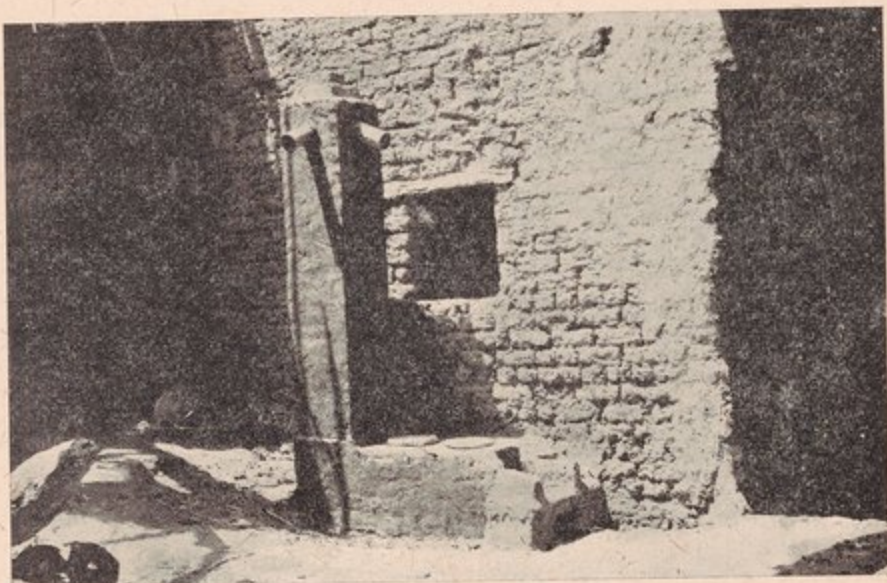
الصورة رقم ٢٠ - الموقد الرقيق المحسن وقد تم بناؤه وأعد للاستعمال .
