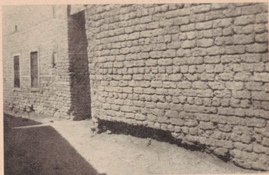
الصورة رقم ٢ - جدار أحد المساكن المبنية باللبن وقد تآكل الجزء السفلي منه (قرية قلتي الكبرى) .
