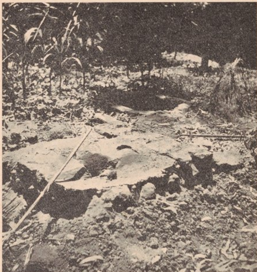
الصورة رقم ١٨ - مرحاض المجرور ( البلدى ) ويظهر مكان التبرز فى الجزء الأمامى من الصورة وإلى الخلف توجد البيرة التى تصرف إليها الحمأة .
