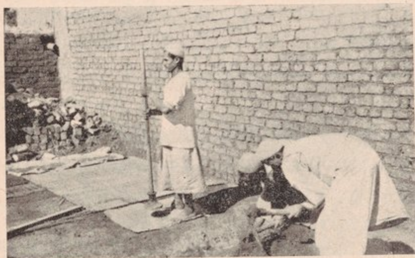
الصورة رقم ٢٣ - طريقة الدك النظيف باستعمال ورق (شكاير) الأسمنت .
