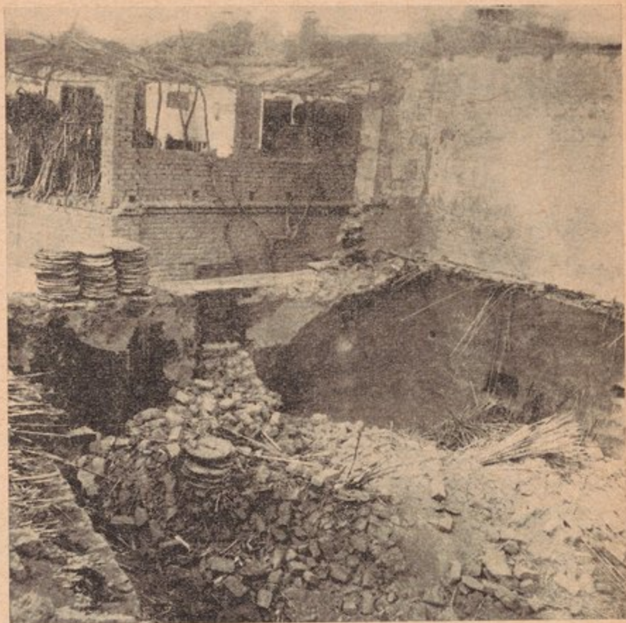
الصورة رقم ٥ - انهار هذا المسكن في قرية قلبي الكبرى بسبب قاذف كل الجدران المبنية من اللبن .
