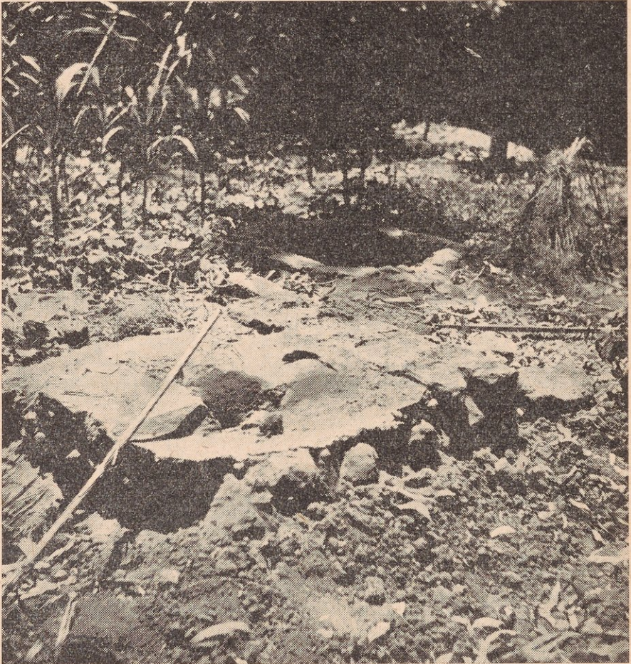
الصورة رقم ١٨ - مرحاض المجرور ( البلدى ) ويظهر مكان التبرز في الجزء الأمامى من الصورة وإلى الخلف توجد البئارة التى تصرف إليها الحمأة .
