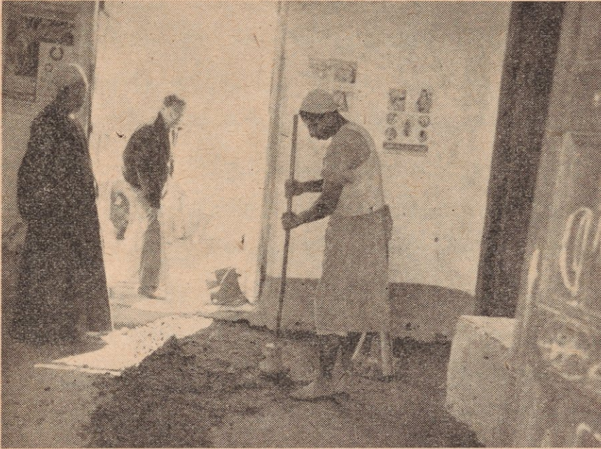
الصورة رقم ٧ - أرضية محسنة مصنوعة من خليط التربة والأسمنت المسمى (landcrete) بقرية دبركي بمديرية المنوفية .
