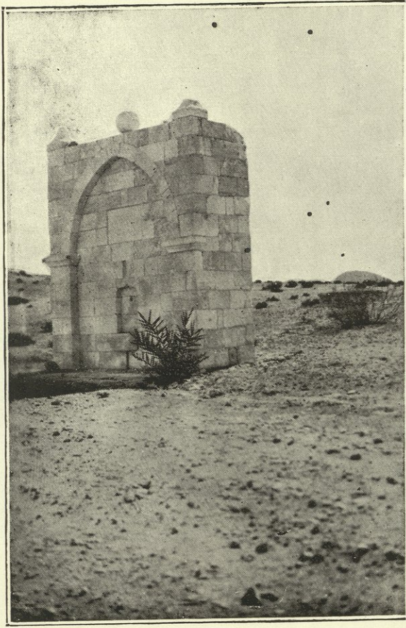
١٢٥ — القصبة — من بقايا عمارات الأتراك أيام الحرب الكبرى
