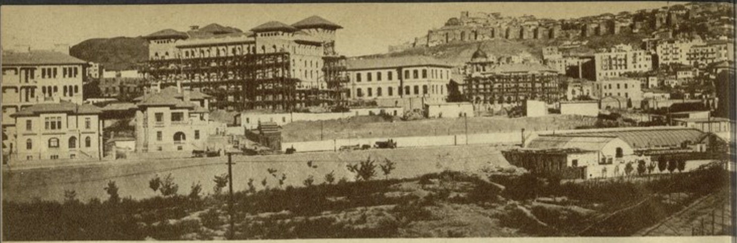
منظر عام لأقصر المنشأة على الطراز الحديث
