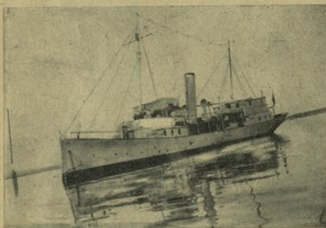
الطوافه مناجم التابعة لمصلحة خفر السواحل وهي ممددة لتأمين بعثة مصلحة المناجم التي تنقب عن زيت البترول على شاطئ البحر الاحمر
