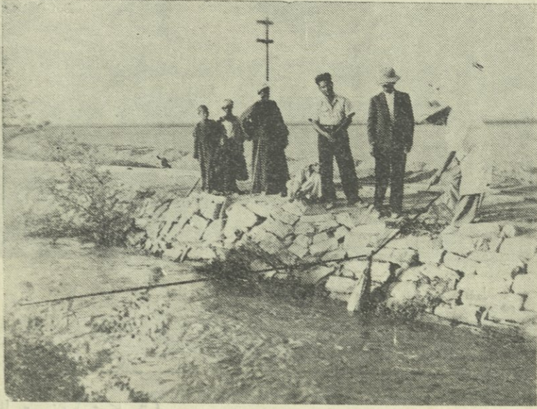
شكل ( ٧ ) شد الكيس من الماء لتغييره بآخر بدون الالتجاء إلى فك الحبل
